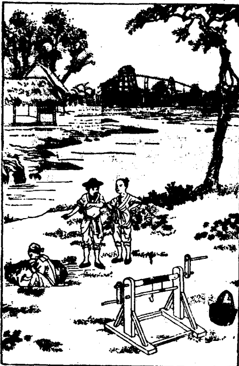
图 1-3 《天工开物》中的“开井口” 相当现在的第一次开钻。
