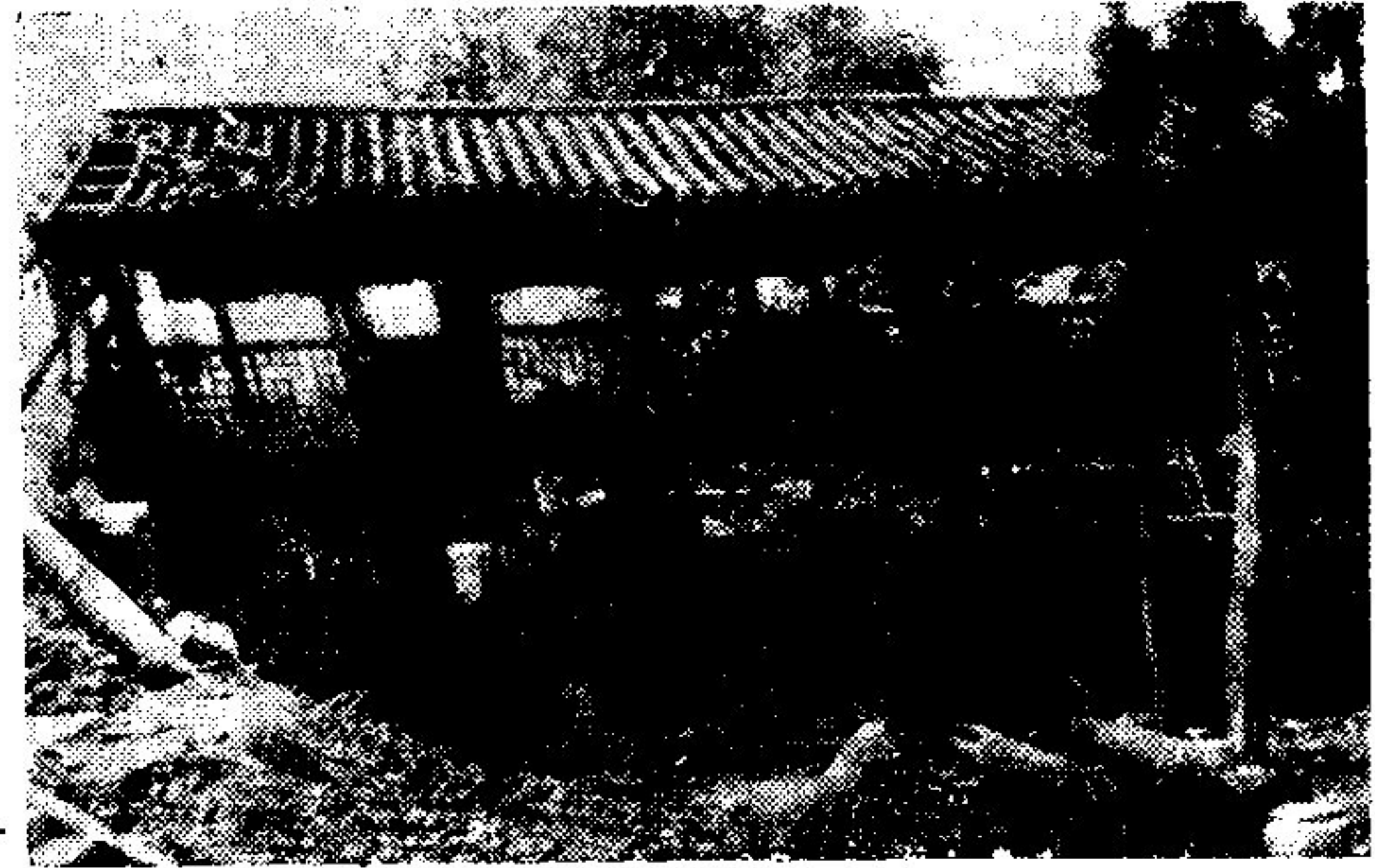
图 3 穿斗木构架房屋围护墙倒塌, 构架严重倾斜
