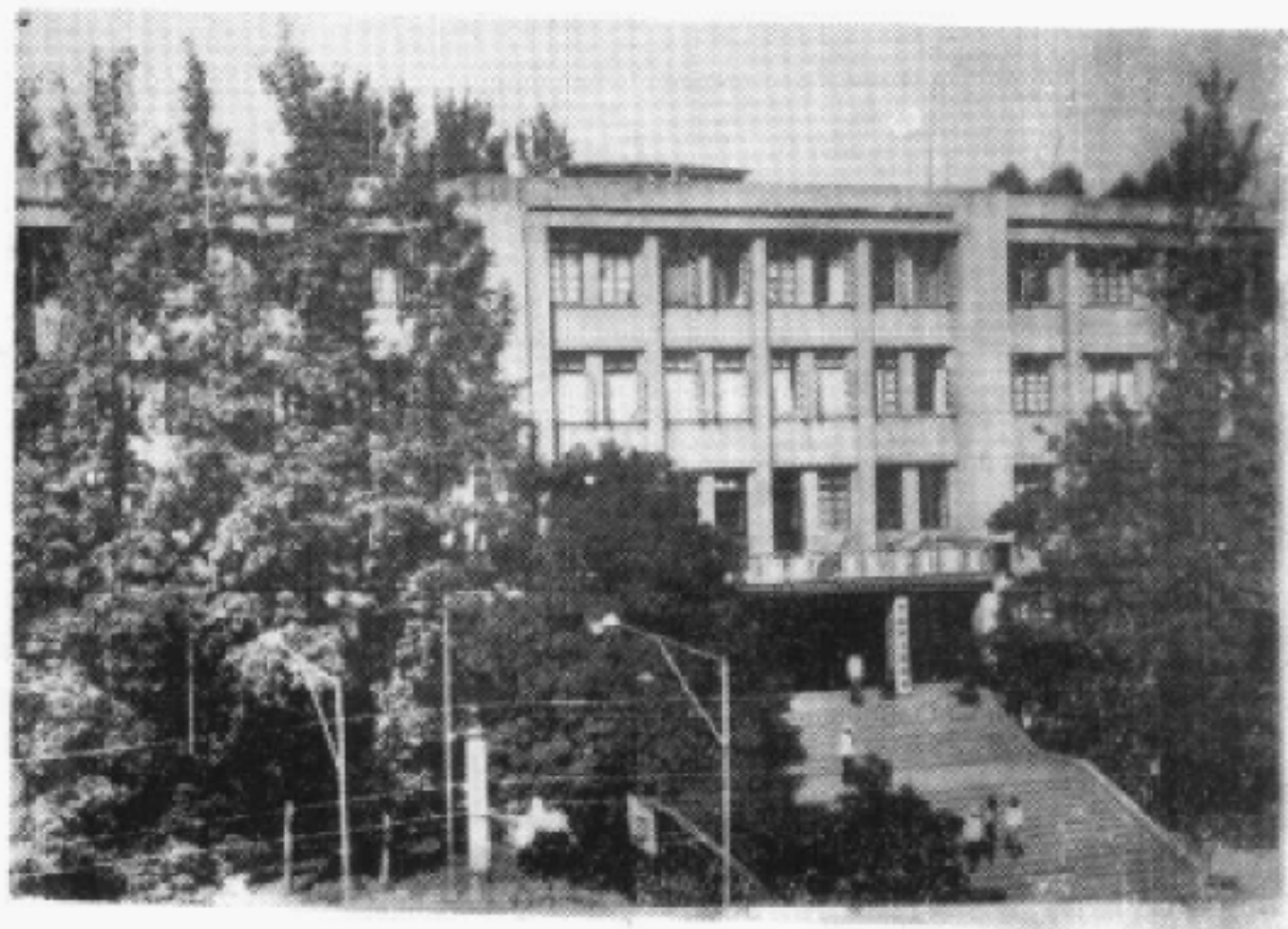
图为中共竹山县委、县人夫、县人民政府、县政协办公大楼
