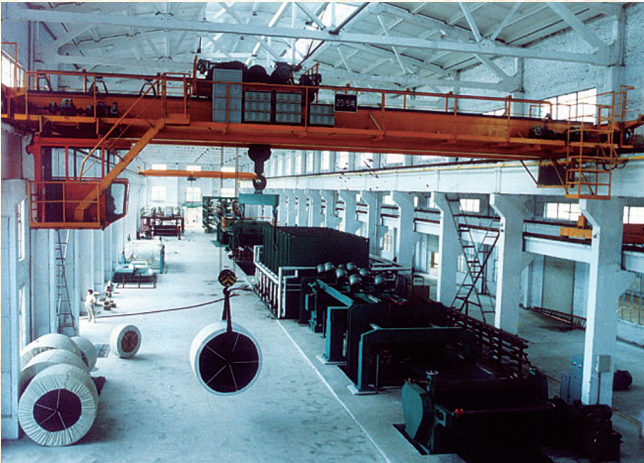
浙江双箭橡胶股份有限公司胶带生产车间
