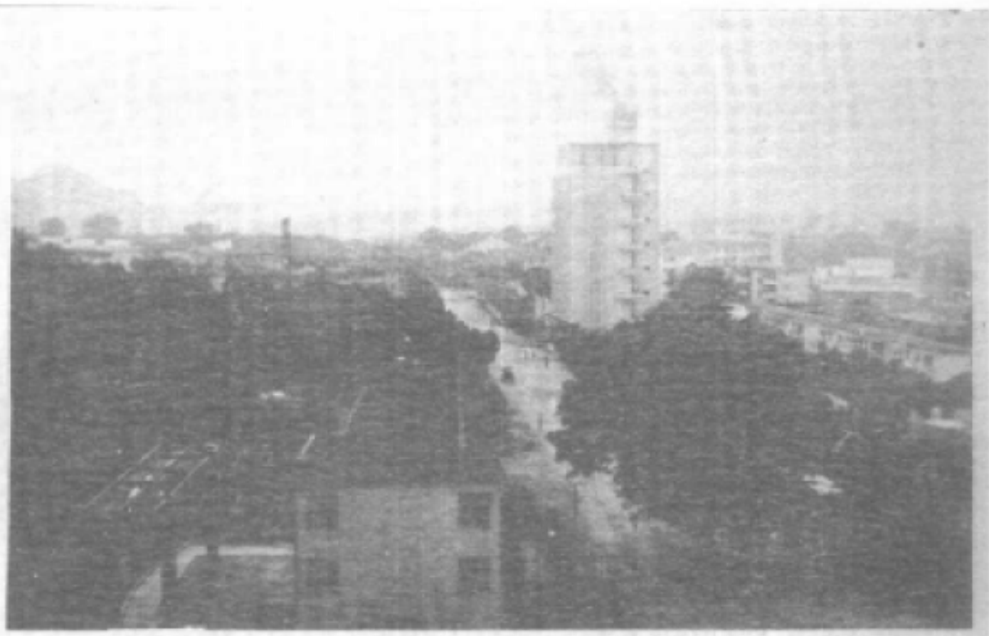
钟山县电视大楼
