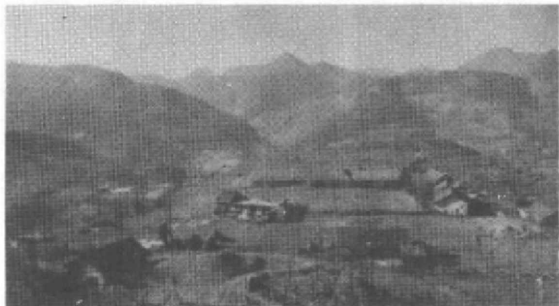
原福集厂中心区（宝钱局，校场坝，生产指挥机关）陈安全 摄
