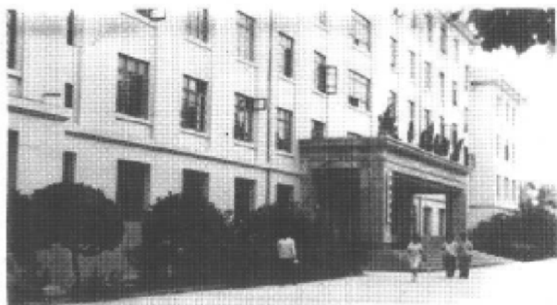
水城矿务局机关办公楼 章继龙 摄
