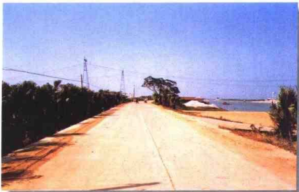
中顺大围干堤实现堤路结合（图为小榄镇堤段）
