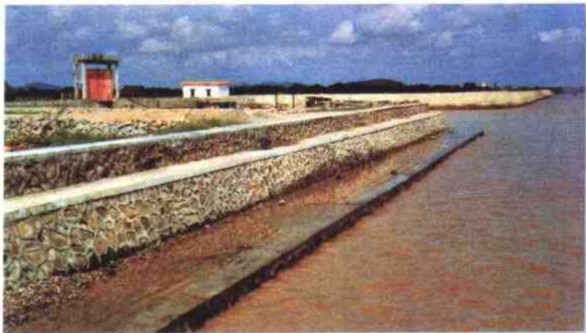
张家边联围三级海堤砌石，可抵御台风暴潮以及频繁的高速船浪冲击。
