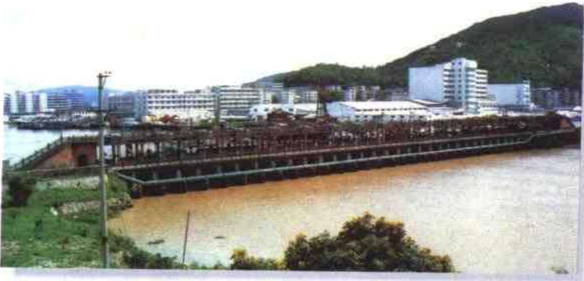
中珠联围石角咀水闸29孔净宽91米
