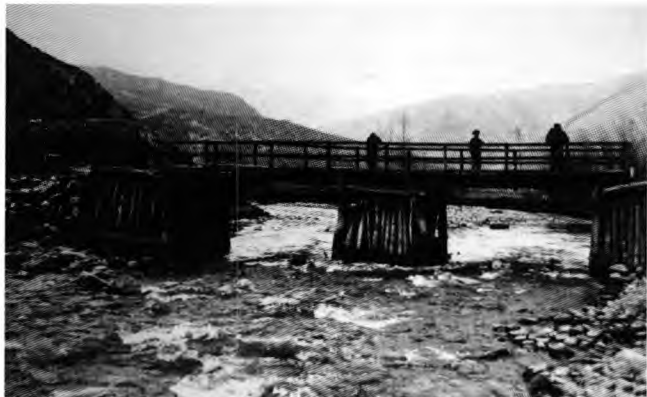
图7 西藏拉萨木墩木梁桥（现已拆除）
