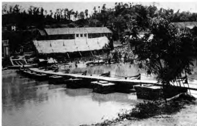
图8 重庆打磨滩浮桥(现已拆除)
