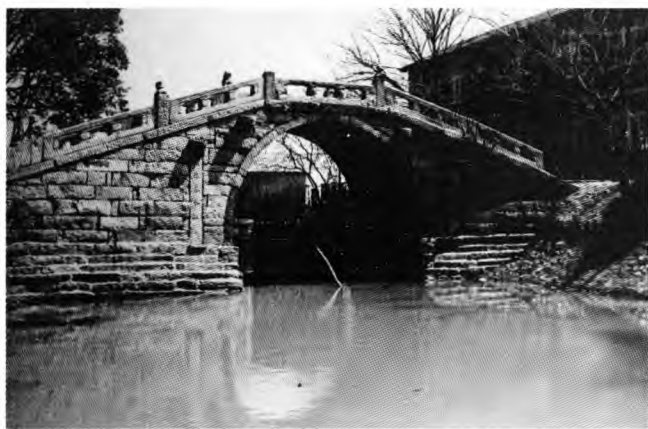
图 22 江苏苏州虎丘塔影桥
