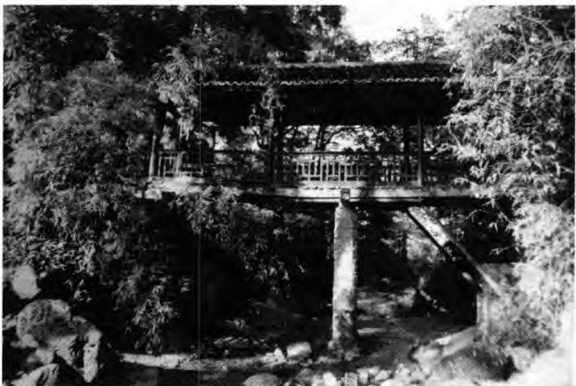
图11 四川峨眉山虎浴桥
