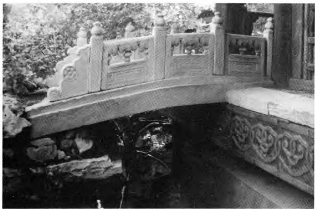
图2 北京故宫御花园跨楼石桥
