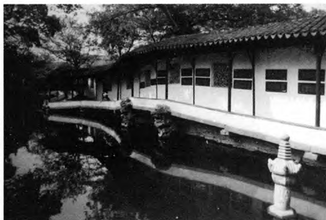
图13 江苏苏州拙政园贴水游廊桥
