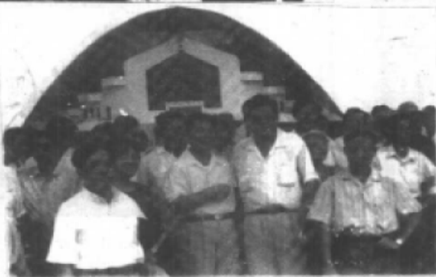
◀市体育中心建设指挥部总指挥吴驹贤陪同市人大领导黄荣、梁友贤等视察体育中心工程进展情况。
