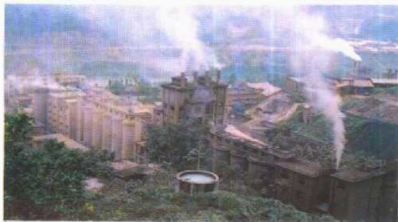
长阳水泥厂一角
