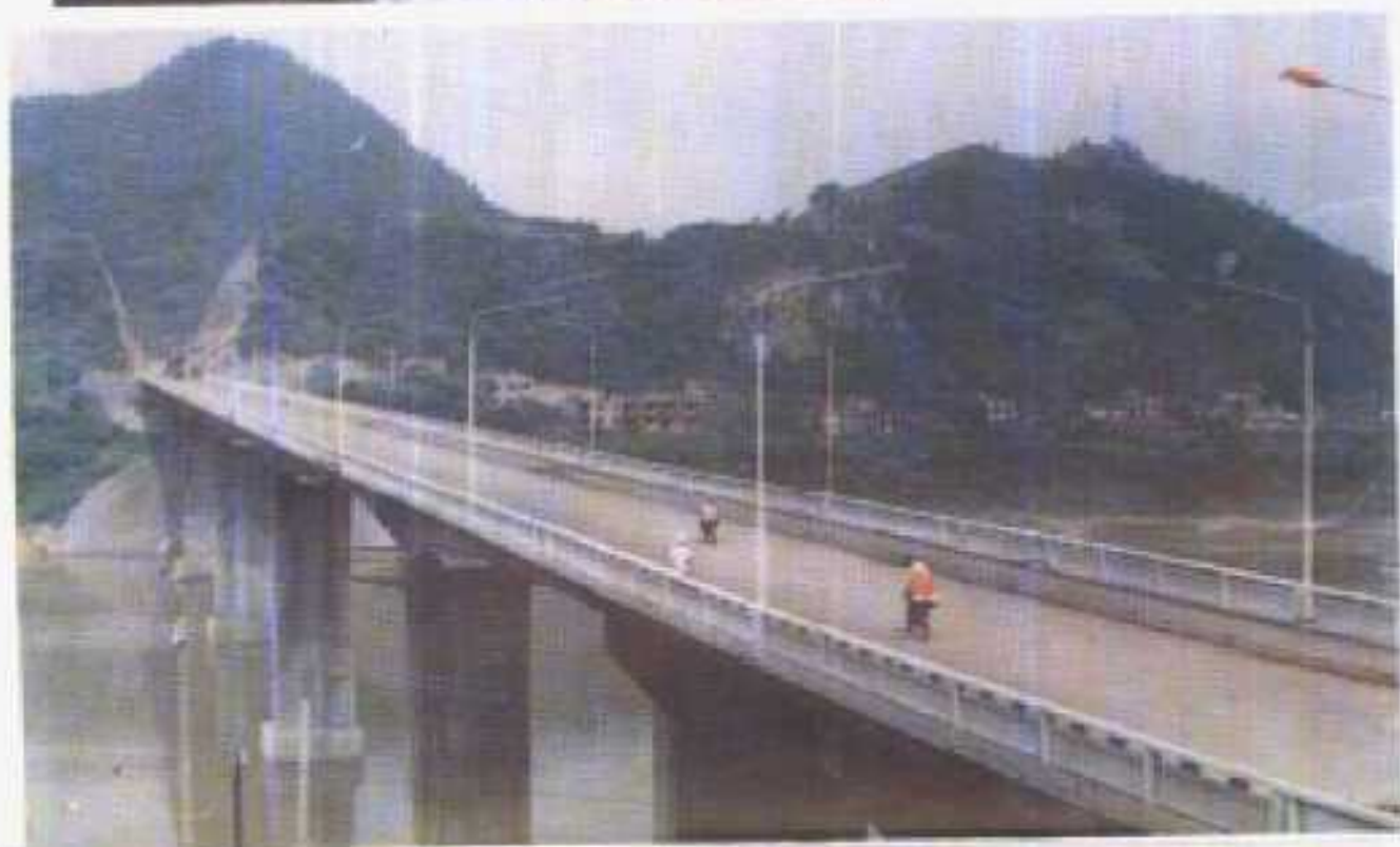
▼南北飞跨 1991年 通车的三里店清江大桥
