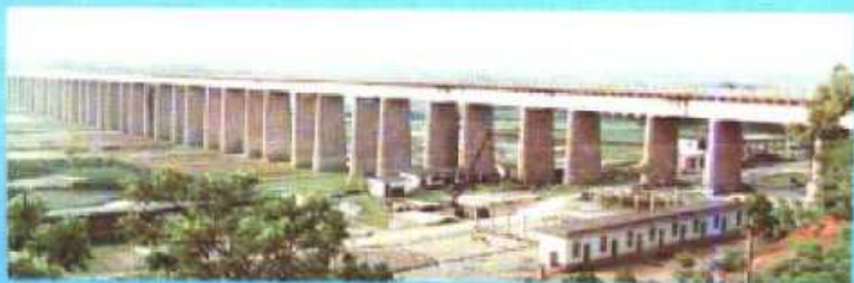
雷州青年运河新桥大渡槽
