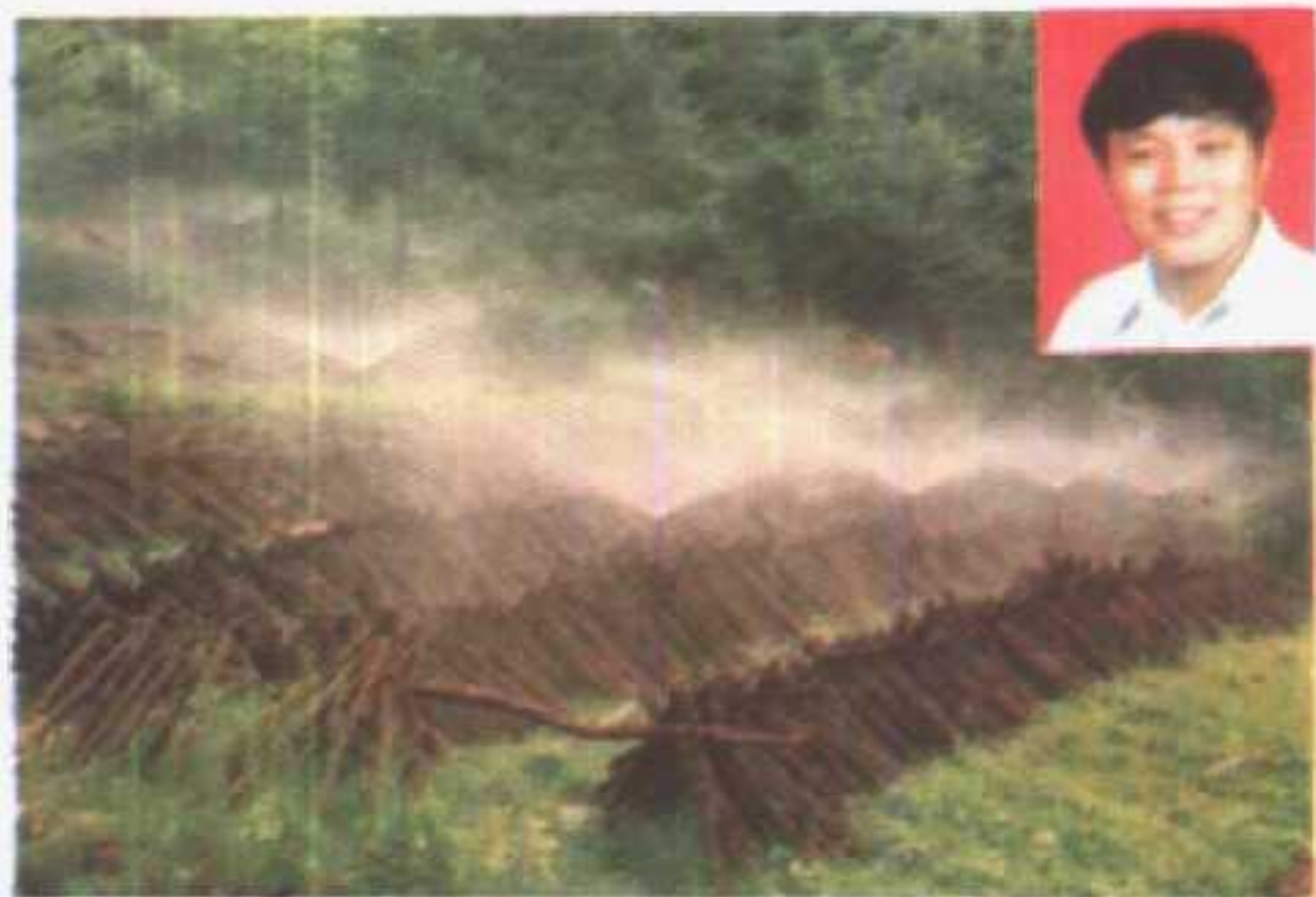
△承建的固定式喷灌工程△法人代表杨少清 ▽正在安装的 \phi 355 型 PVC 输卤管
