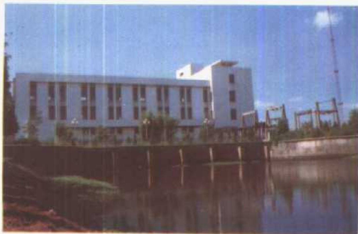
▽承建的云梦县公路口泵站泵房
