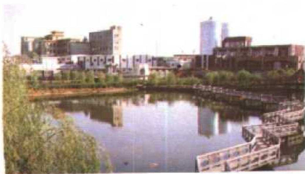
◁ 第二粮油厂厂区全貌
