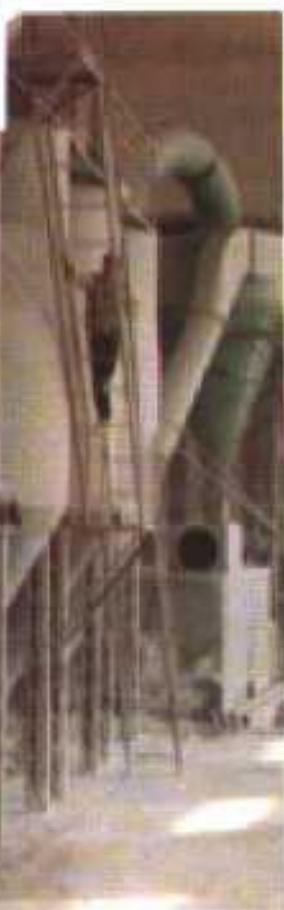
石膏制品厂制粉车间
