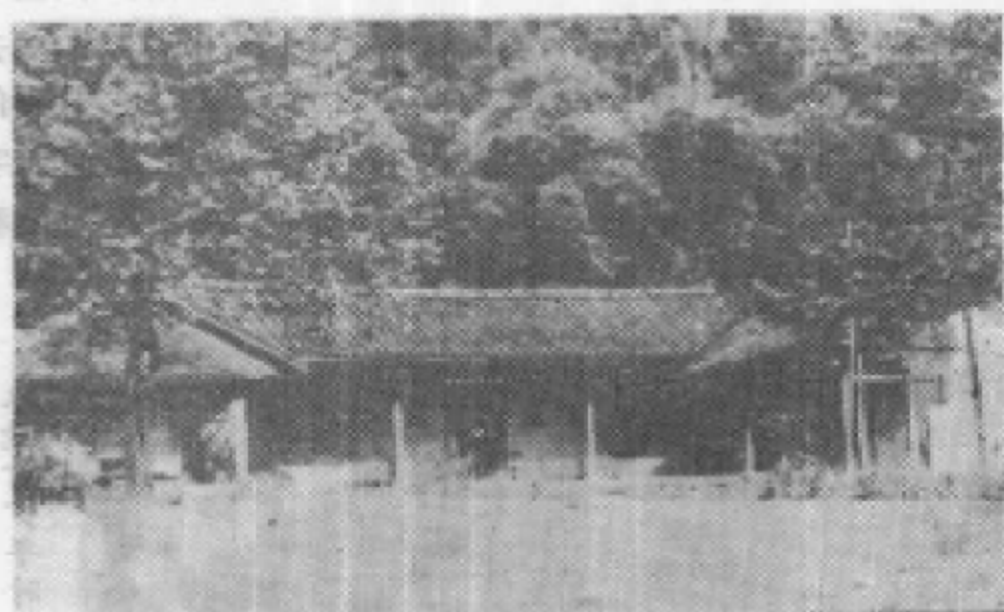
朱德故居—马鞍山大湾老屋（1895—1908）
