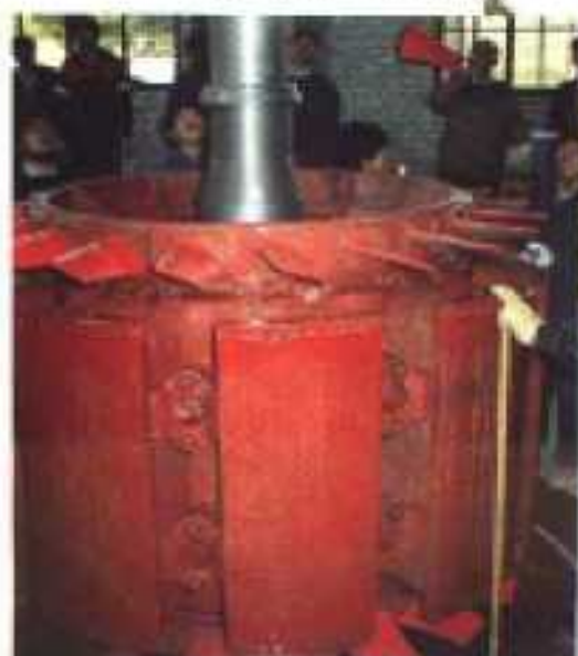
县水电开发公司安装南阳河电站 6300KW 的主式发电机组。
