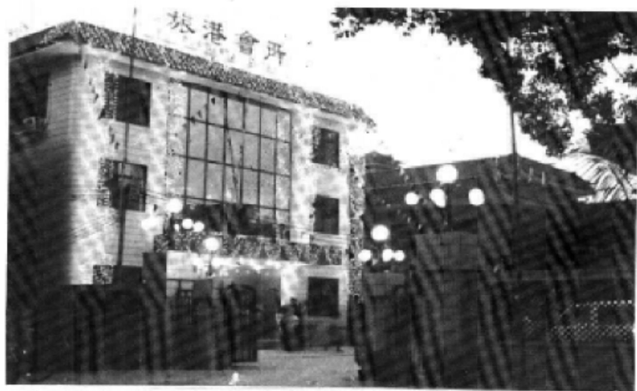
▲旅港同胞捐资兴建的“新兴县旅港新兴会所”。
