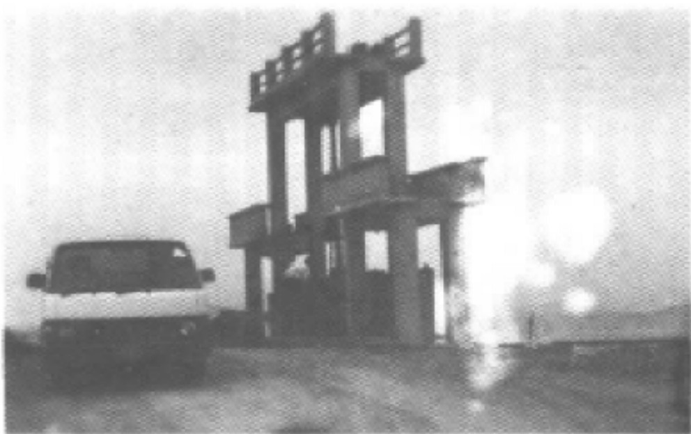
三龙水闸建成通车 (一九八八年)
