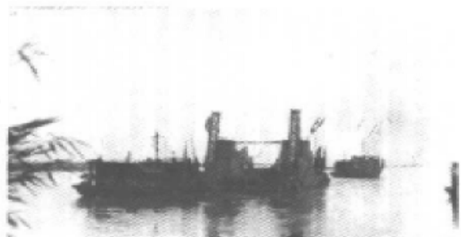
浮运水闸 (一九七七年)
