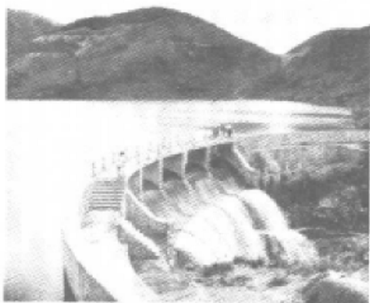
新矿塘水库的 石拱坝
