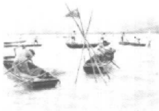
万二亩垦区堤线垫沙的 施工(1975年)
