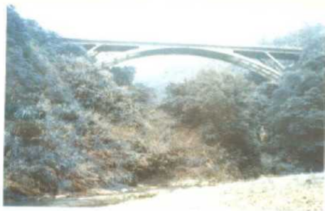
国道 105 线徐坑高架桥
