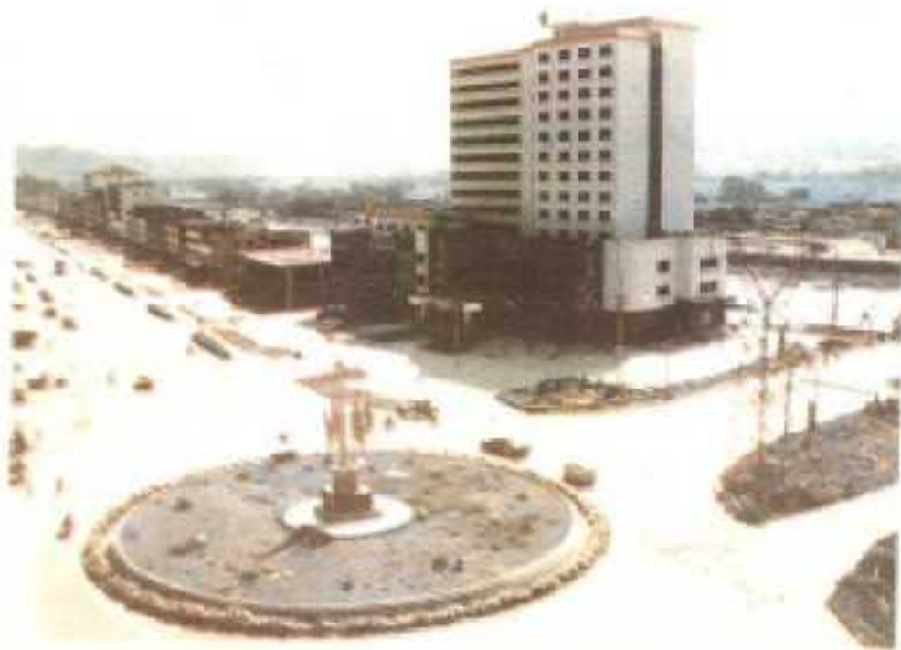
国道 105 线新丰县城路段
