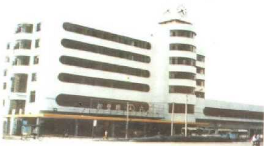
位于国道 105 线旁的新丰县汽车站
