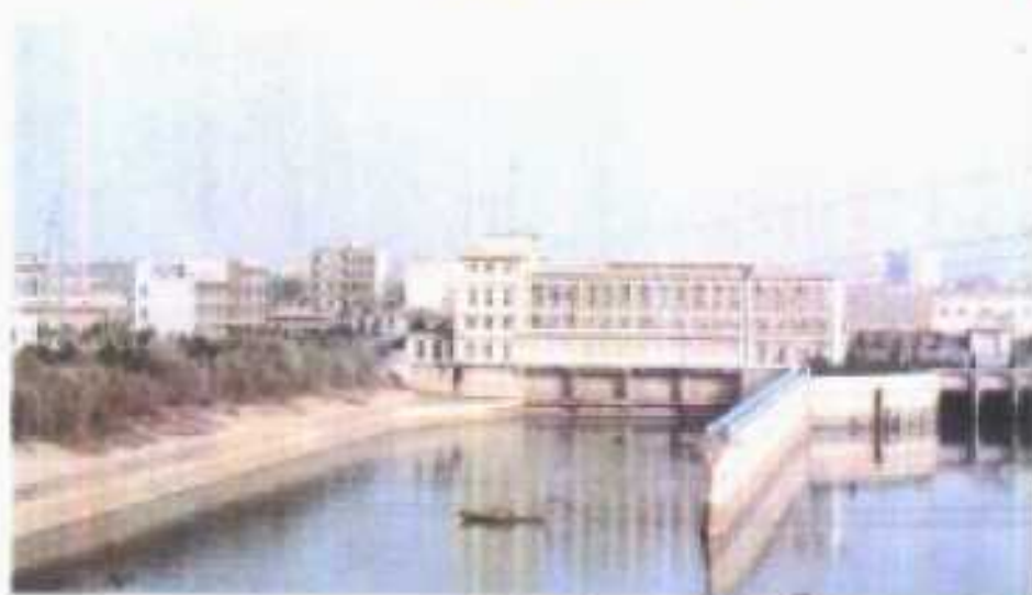
汉川泵站二泵站
