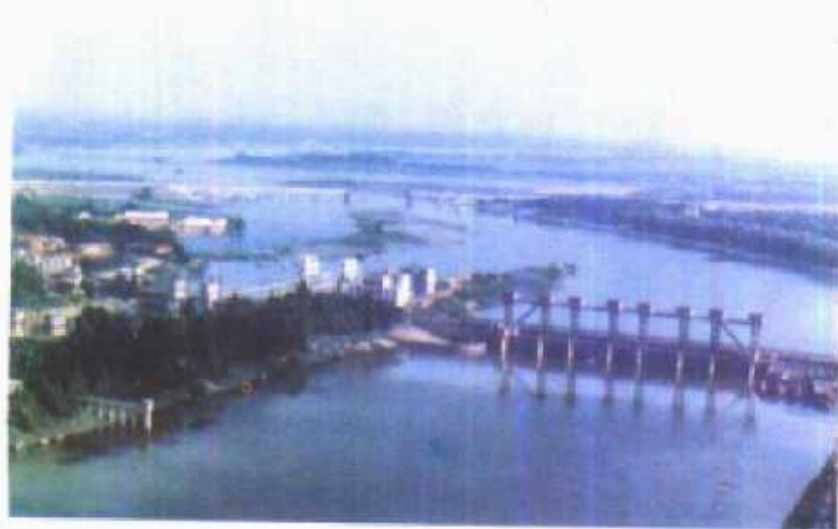
汉北河排洪工程
