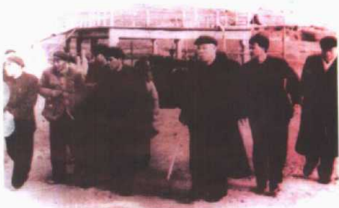
1960年3月6日，董必武在王任重、张体学陪同下 视察徐家河水库大坝施工现场。
