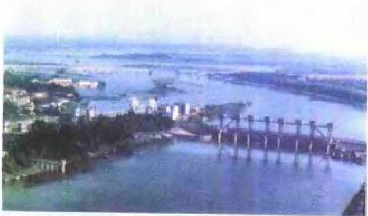
汉北河排洪工程
