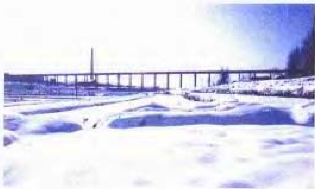
广水市花飞港区南口渡槽
