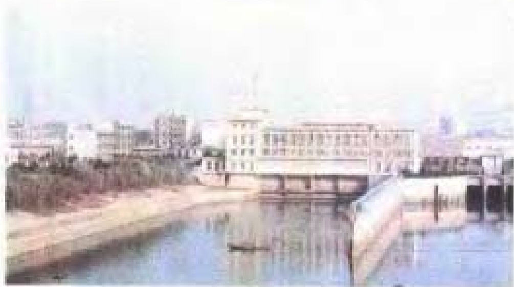
汉川泵站二泵站
