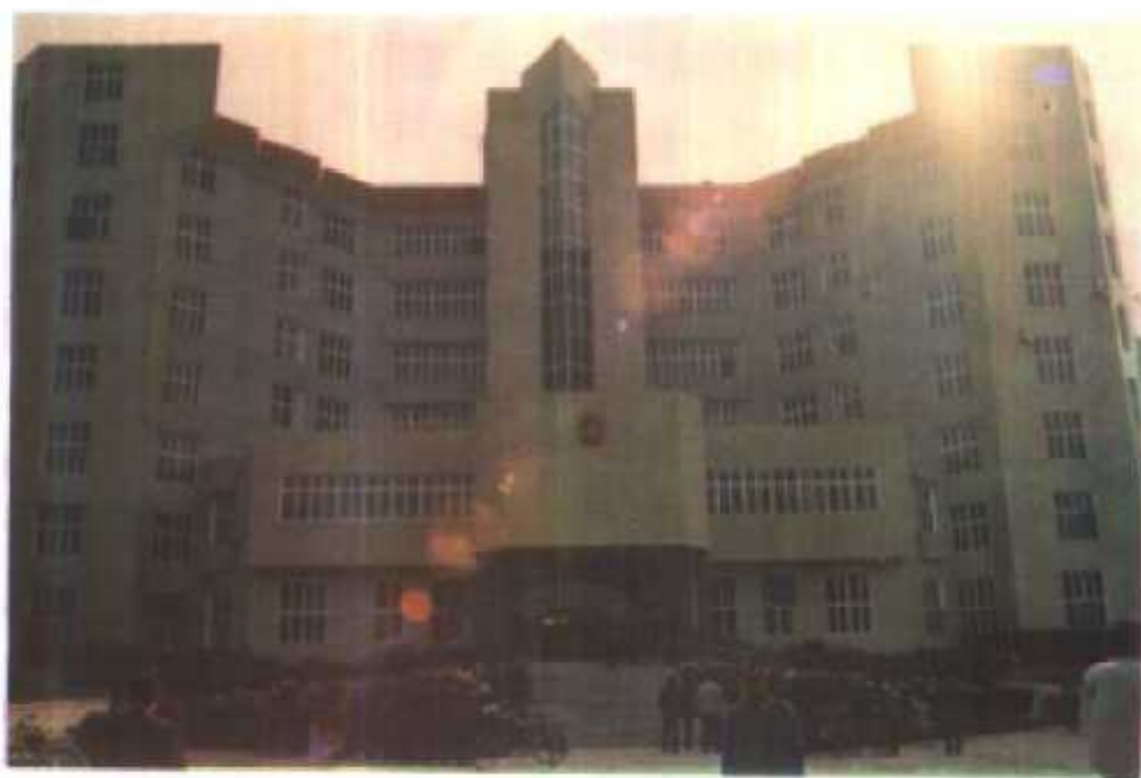
△县政府办公大楼
