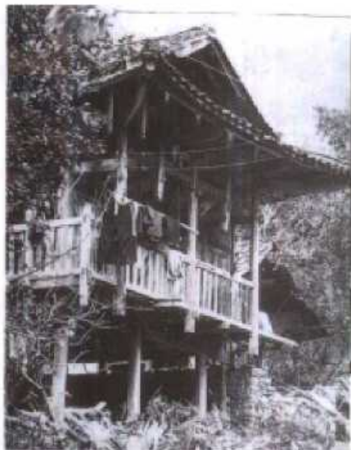
十字路唐家沟游学古住宅(局部)
