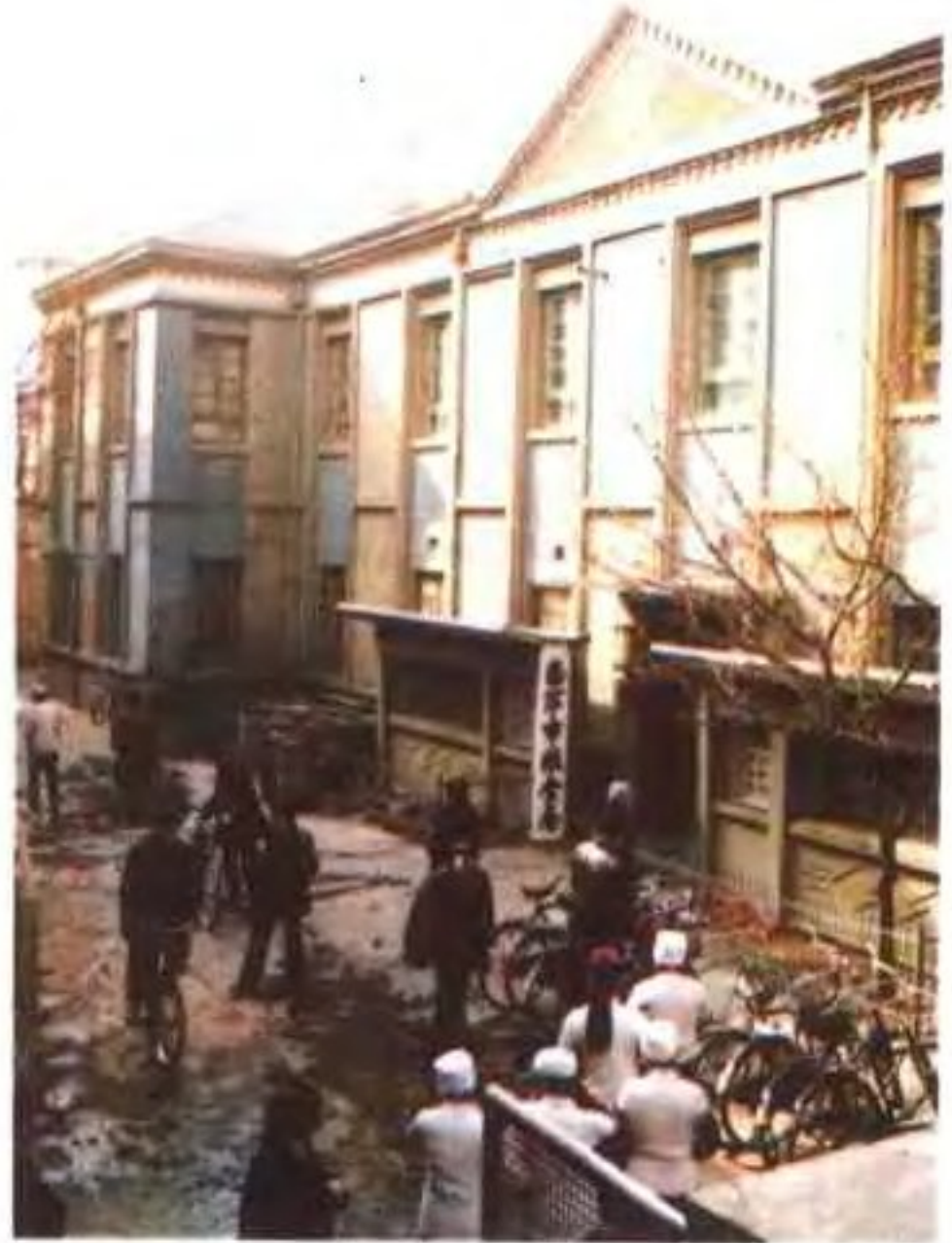
西宁市粮食局办公楼
