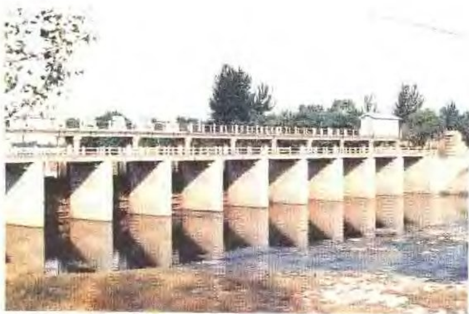
武清县龙凤河十一孔节制闸
