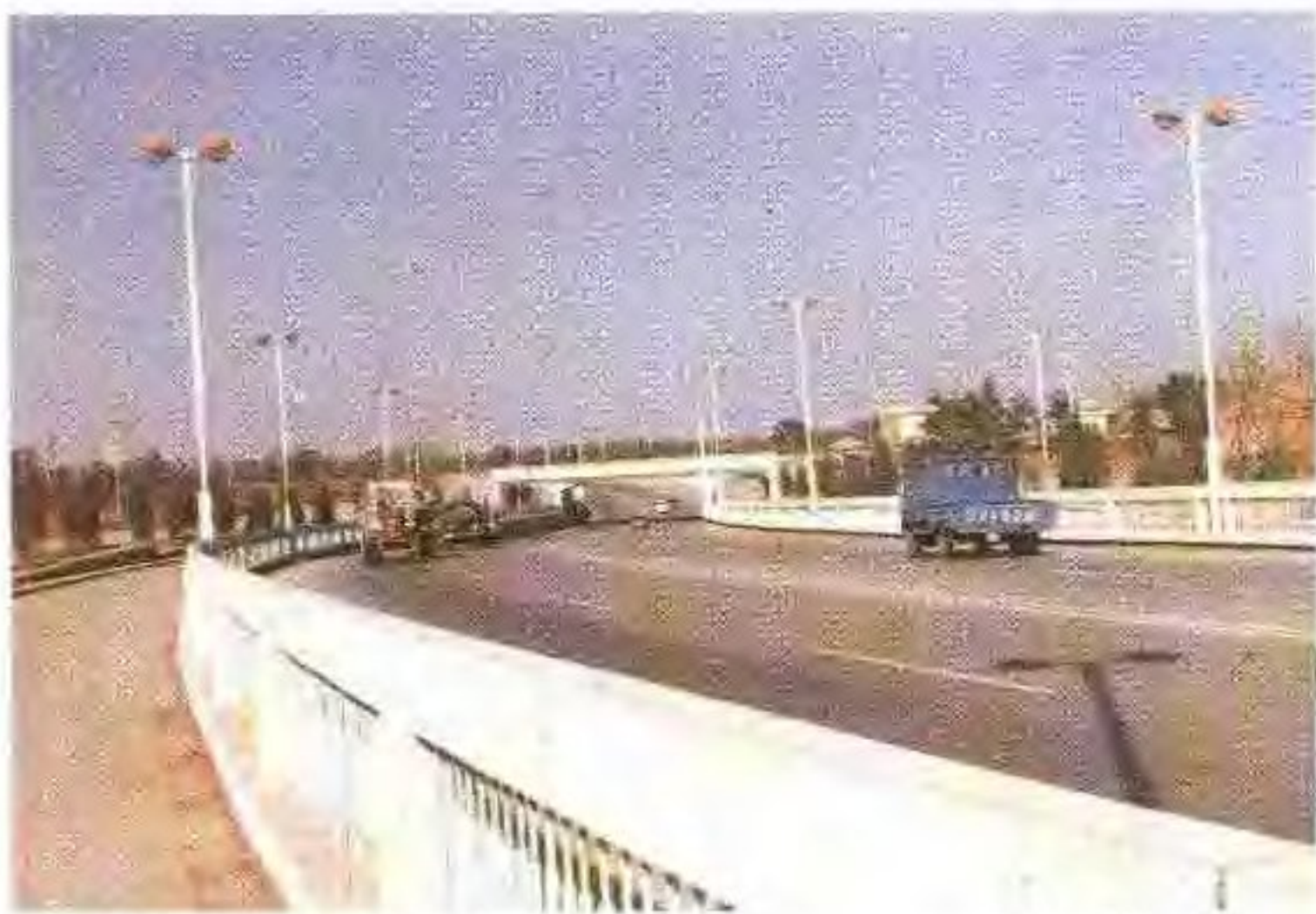
辛庄铁路、公路立交桥
