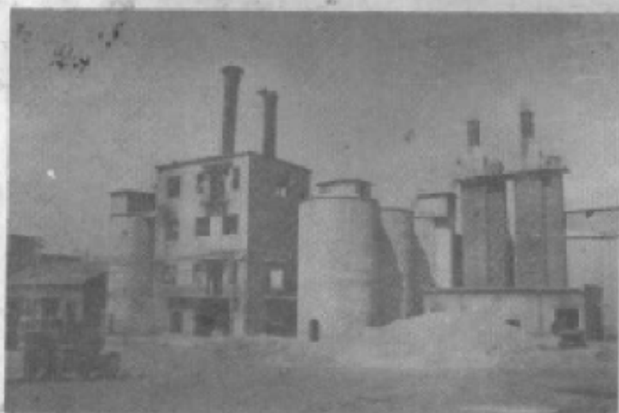
年产三万吨的水泥厂 (均为李旭林摄)
