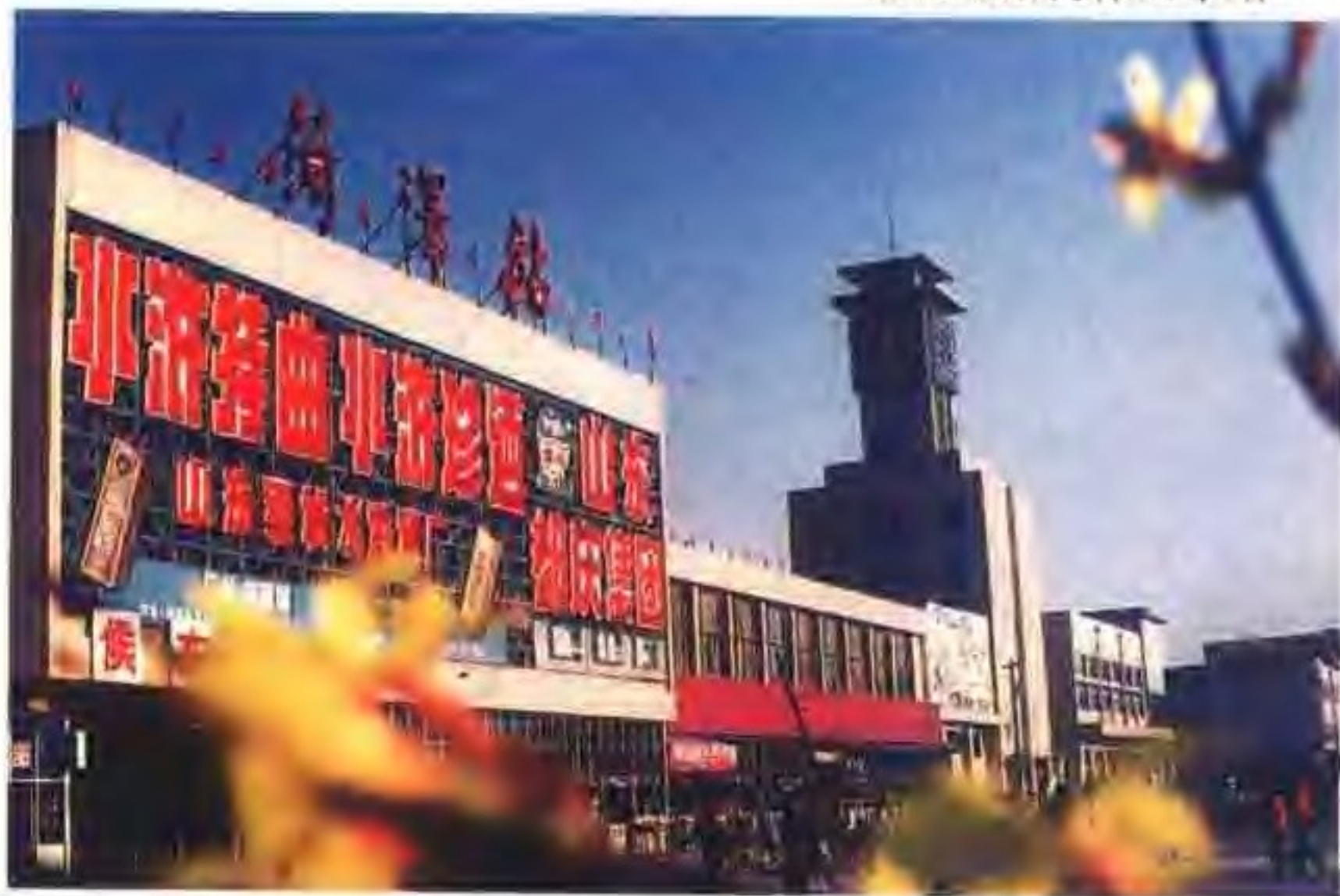
京九铁路菏泽火车站
