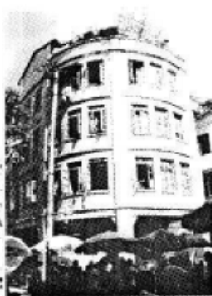
旧址（现居仁路附近）。 ▲解放前的美商美孚火油公司办公楼
