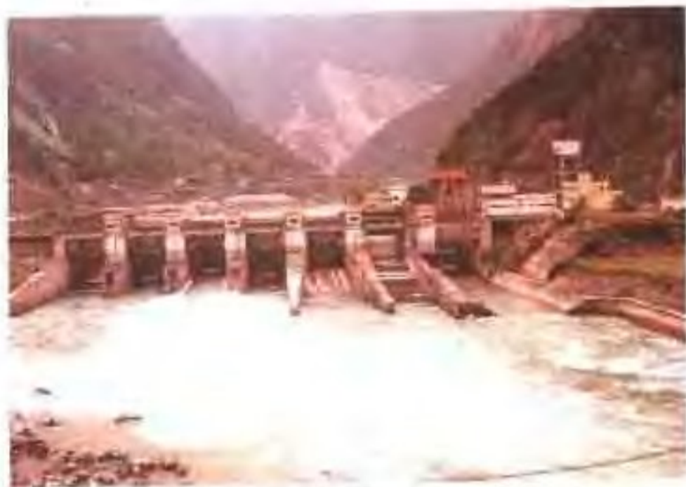
太平驿电厂拦河大坝
