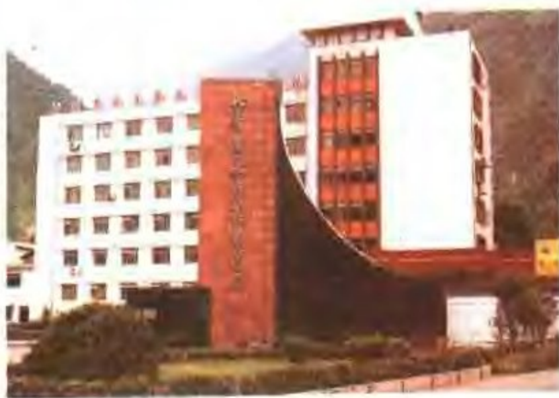
映秀湾水力发电总厂办公区
