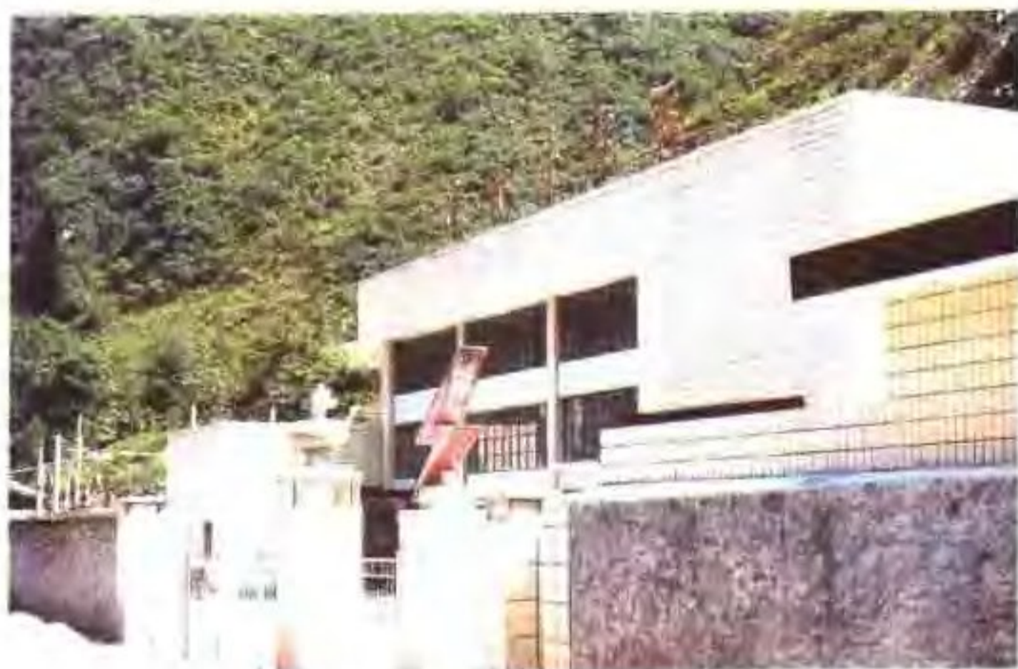
草坡凉水井电站
