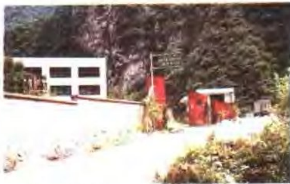
草坡塘房电站
