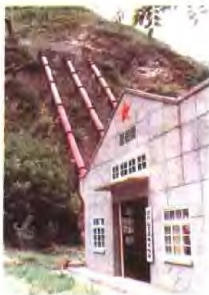
汶川县龙溪乡水电站
