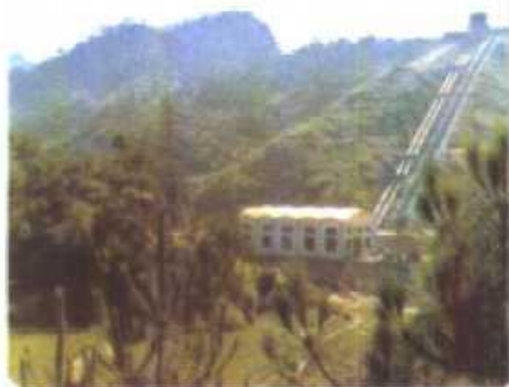
通城县百丈潭 三级电站全貌
