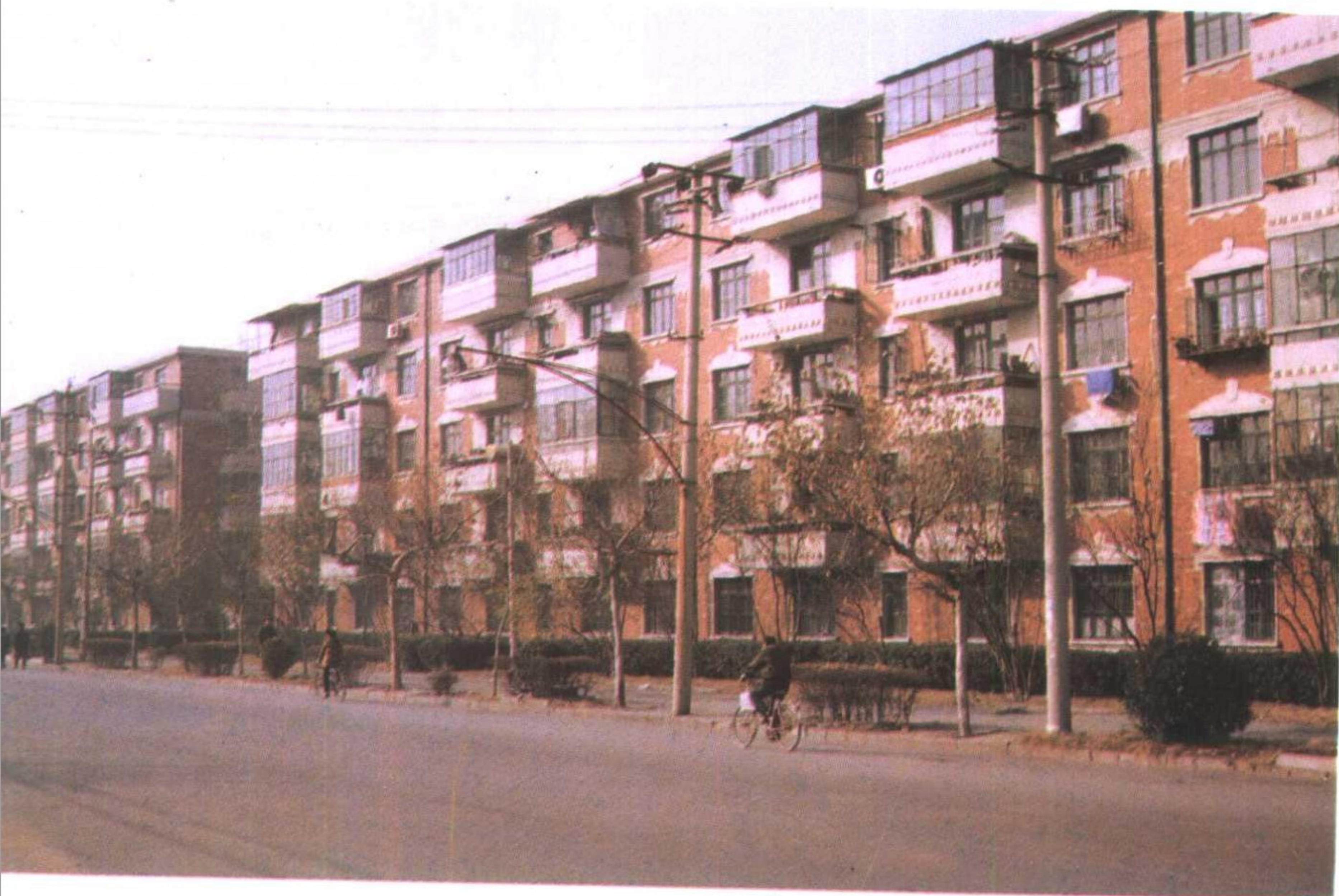
接层后的住宅楼
