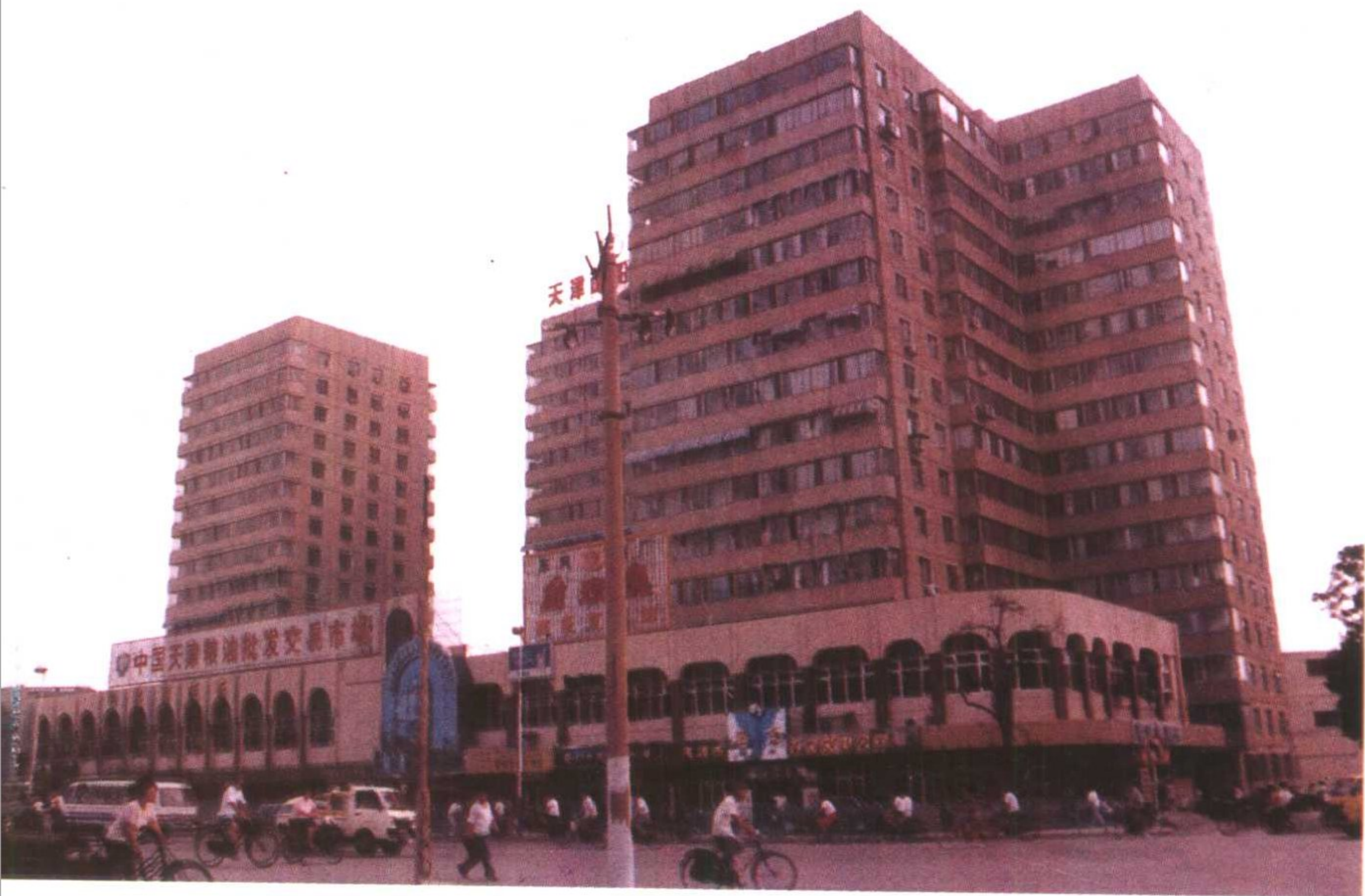
赤峰桥东侧高层住宅
