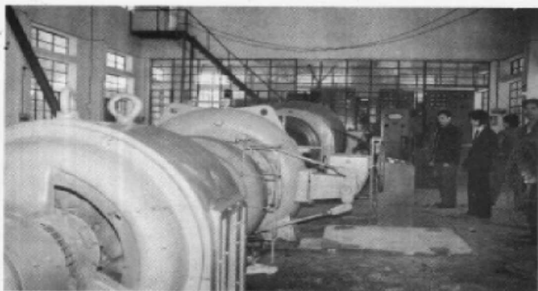
上：中南局第一個水力發電廠——台山縣鰲陂頭水電廠發電車間。
