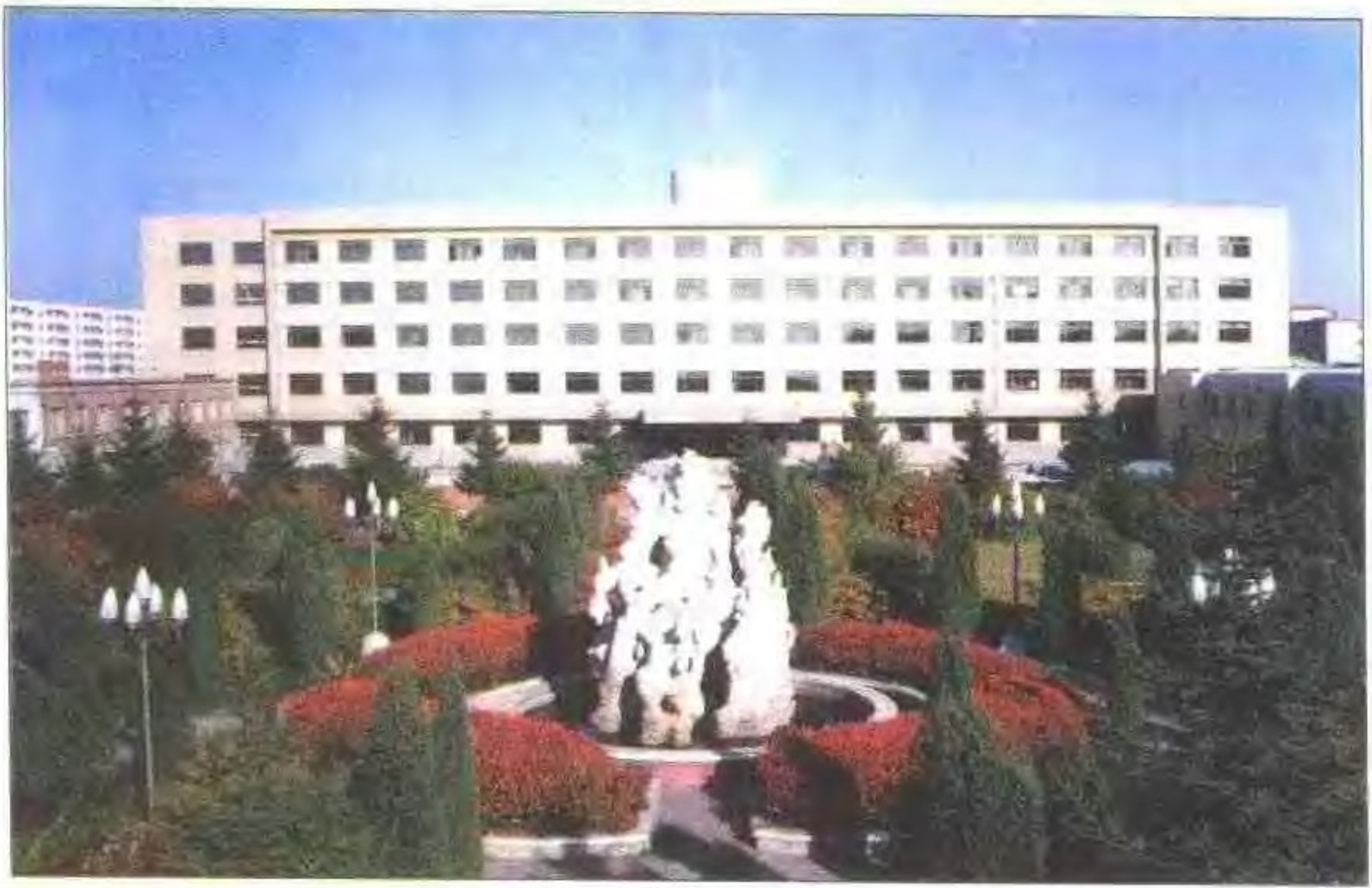
中共黑龙江省绥化地区委员会办公楼
