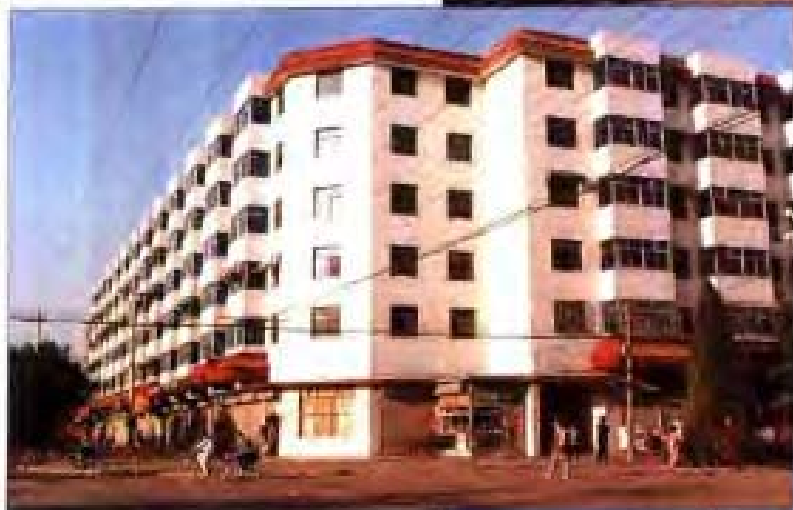
县城商品住宅楼
