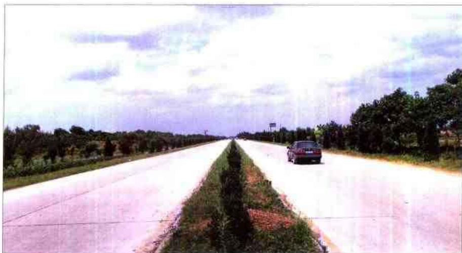
县境内一级钢筋混凝土路面公路
