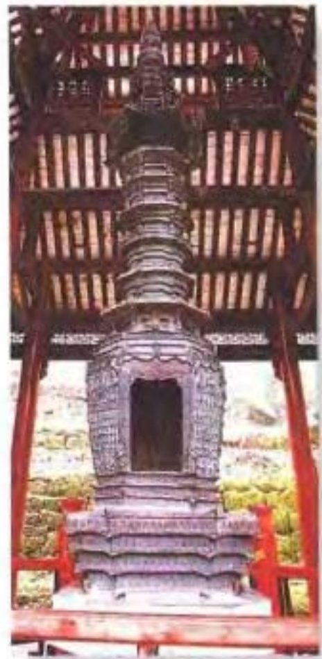
华严经塔 制造铸于1585年, 高5.8米, 14层, 刻有铸佛4700尊和《华严经》全文, 为四川省重点保护文物
