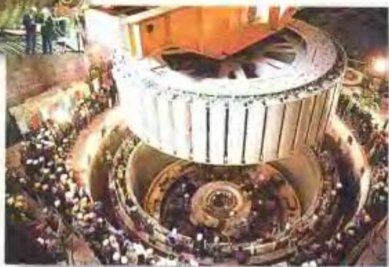
东方电机厂研制的320MW水轮发电机转子吊装， 获1989年四川省科技进步特等奖，1991年国家科技 进步一等奖
