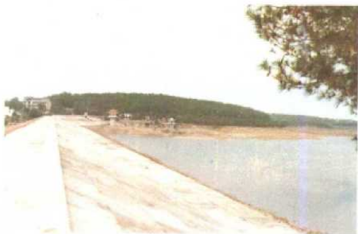
阜阳市大型水库——华阳河水库枢纽工程一角。 (华阳河水库管理处供稿)
