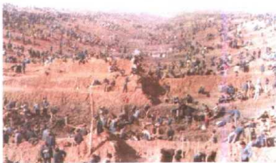
一九九〇年冬，石台寺工程一级站引水口开挖盛况。 (郭仁庆供稿)
