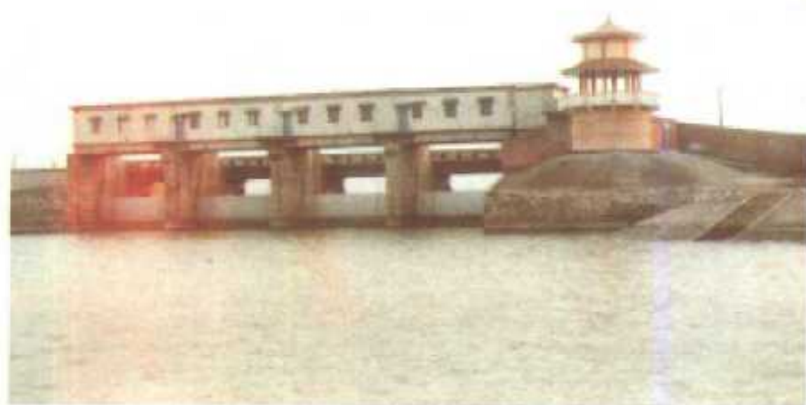
吉河水库溢洪道弧形闸门全景。 (曹台庆供稿)
