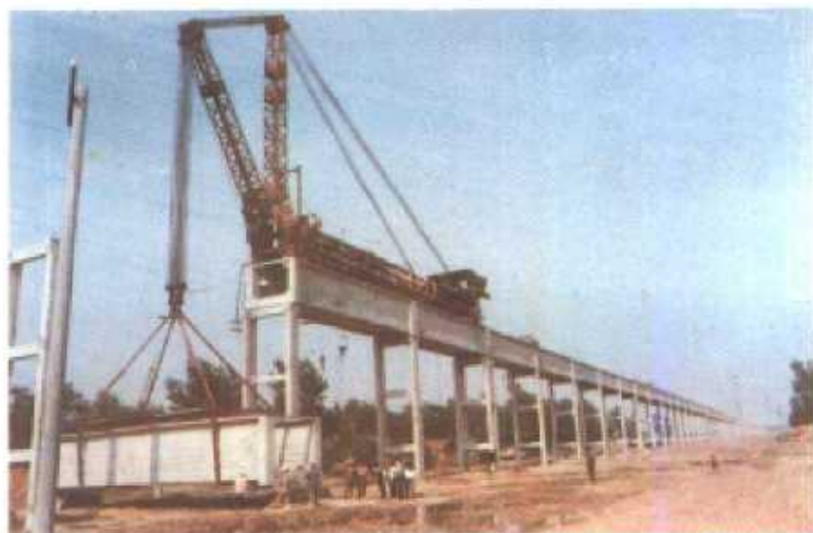
石台寺工程小杨庄渡槽吊装盛况。 (郭仁庆供稿)
