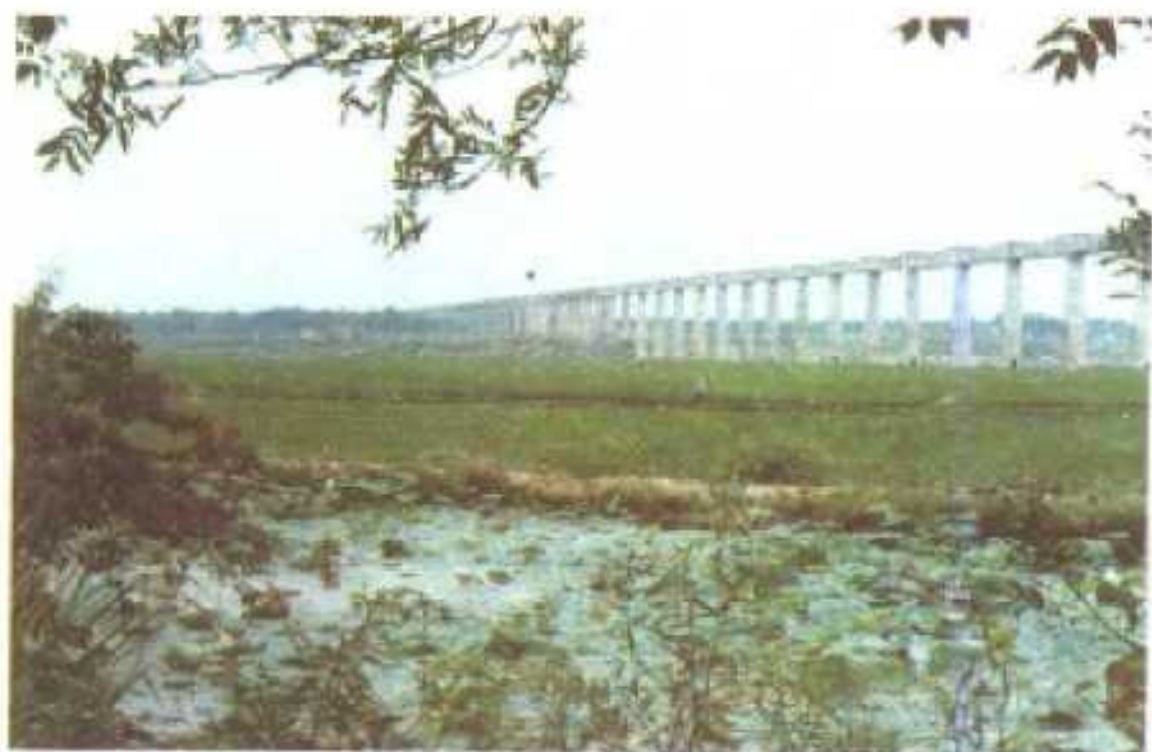
熊河东干渠大渡槽，全长2060米。 (阜阳市水利局办公室供稿)
