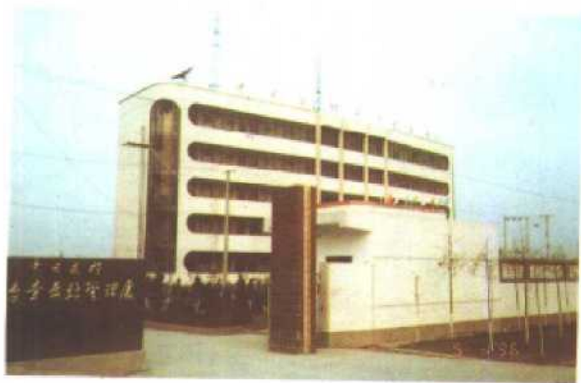
中日友好石台寺泵站管理处外景。 (郭仁茂供稿)
