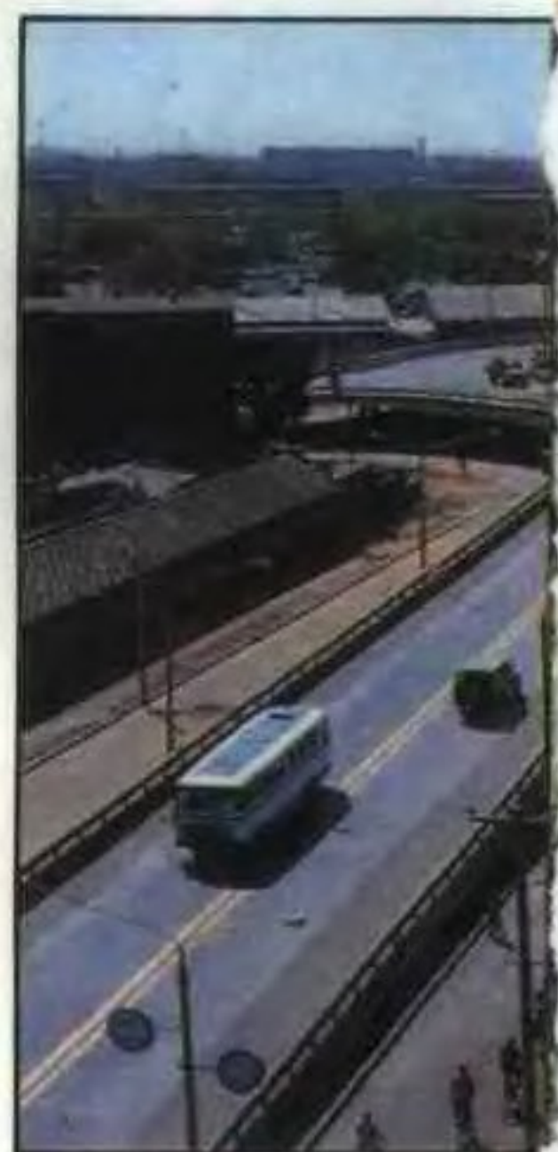
北道岔立交桥
