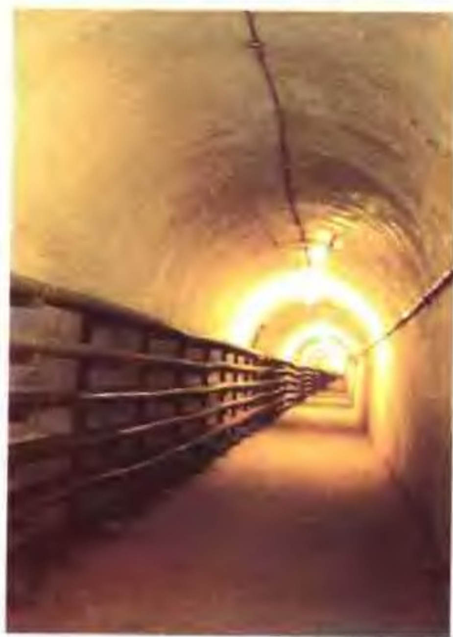
利用人防工程敷设供电电缆
