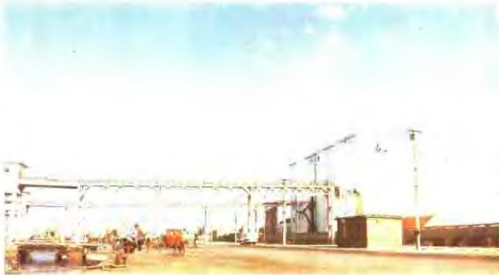
石岛万吨冷库
