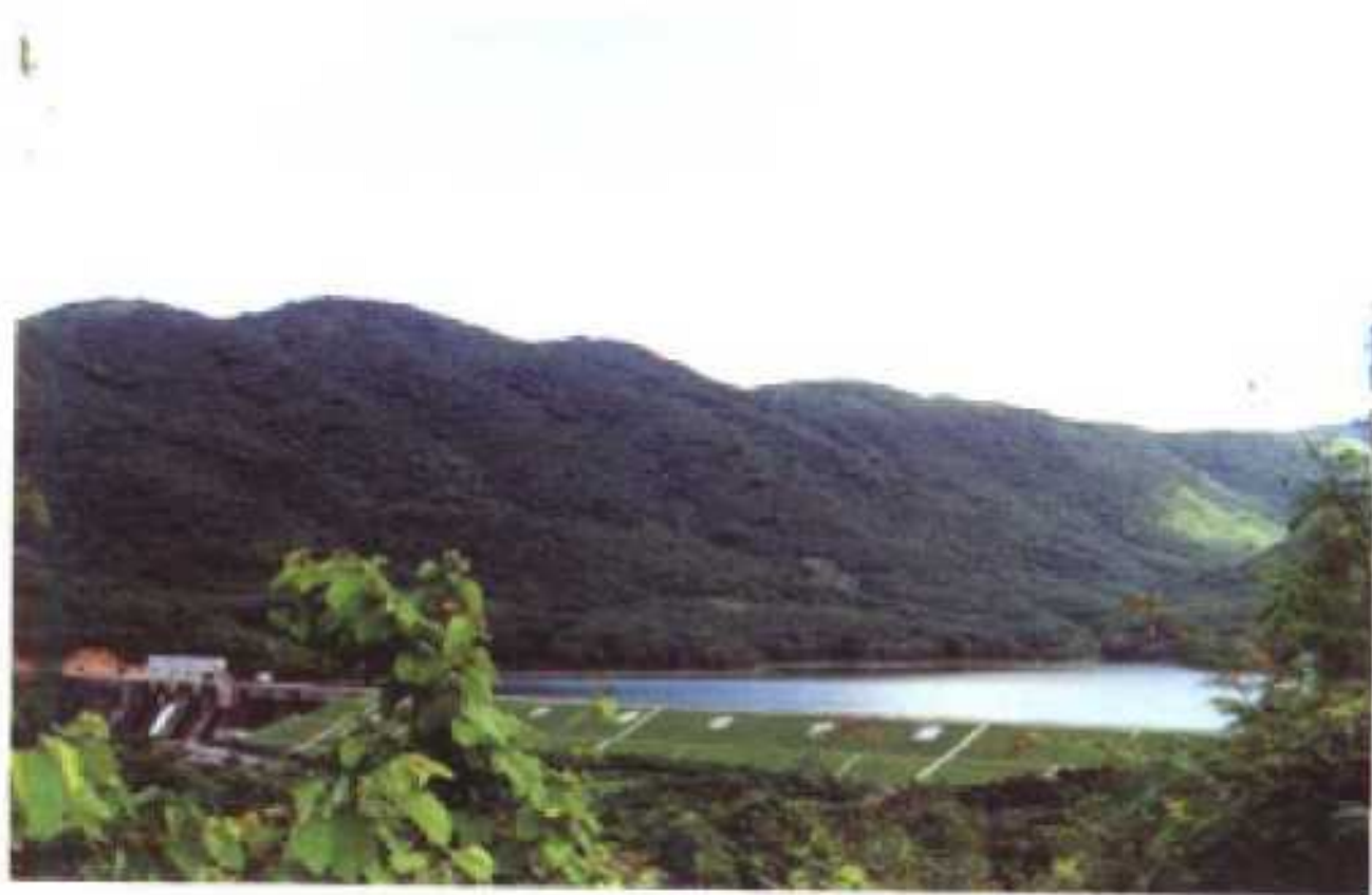
三亚市水源池水库
