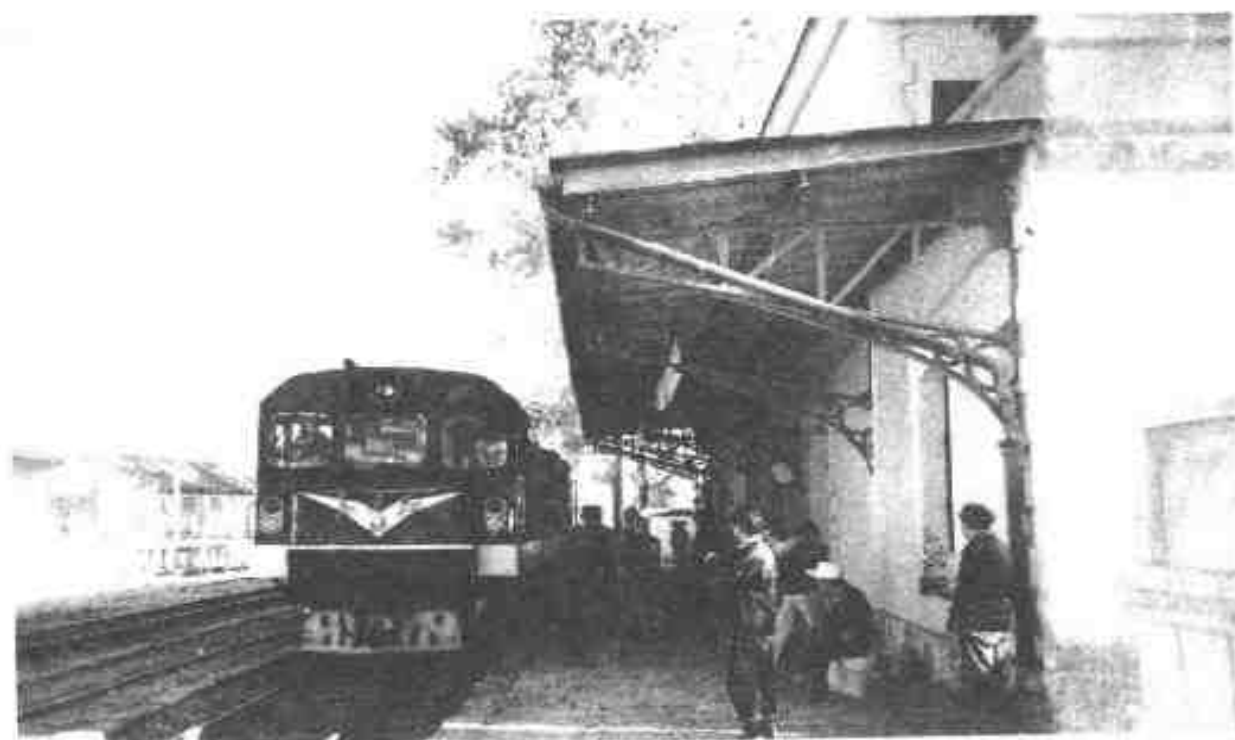
滇南铁路上的碧色寨站
