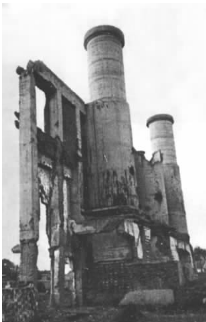
第 731 部队锅炉房遗迹（哈尔滨市平房区）
