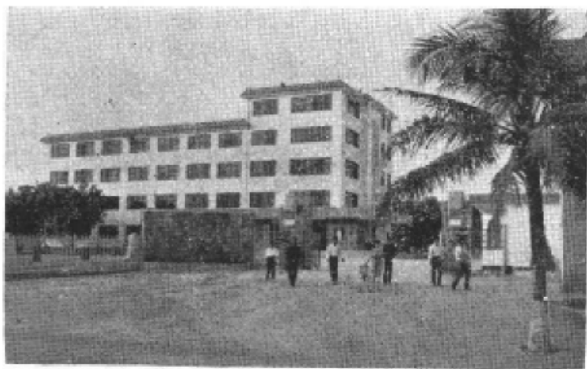
图为：国营大丰农场场部办公大楼
