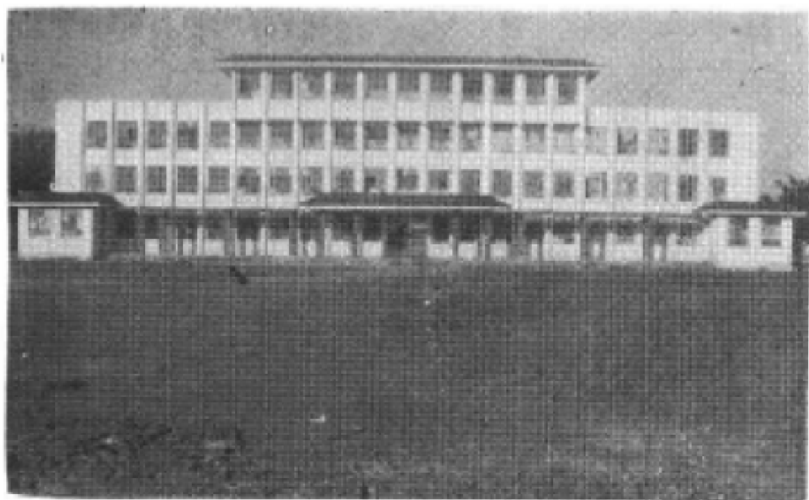
图为：琼中黎族苗族自治县民族中学教学大楼 郑岸 摄
