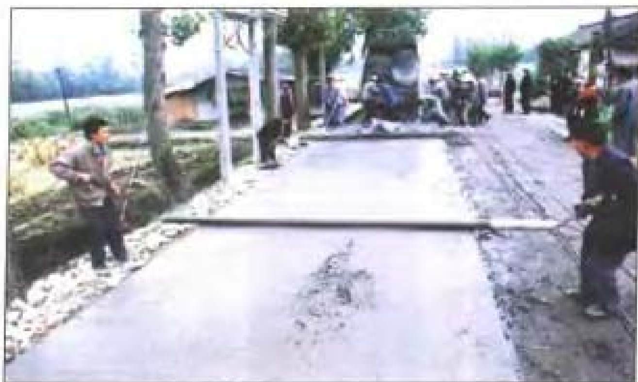
高塘林村村道水泥路施工现场
