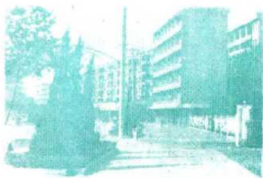
图为新建的武汉石化厂职工宿舍
