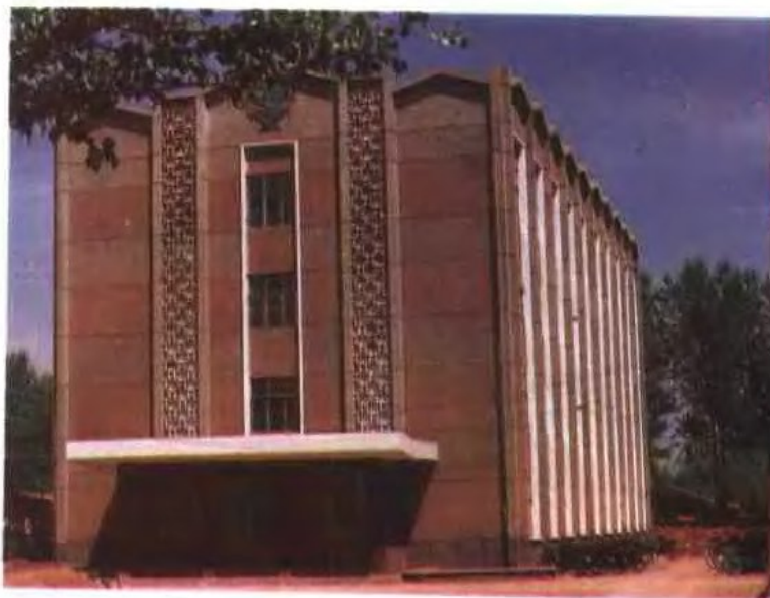
平安县第二建筑公司施工的县中学实验楼，评为优良工程
