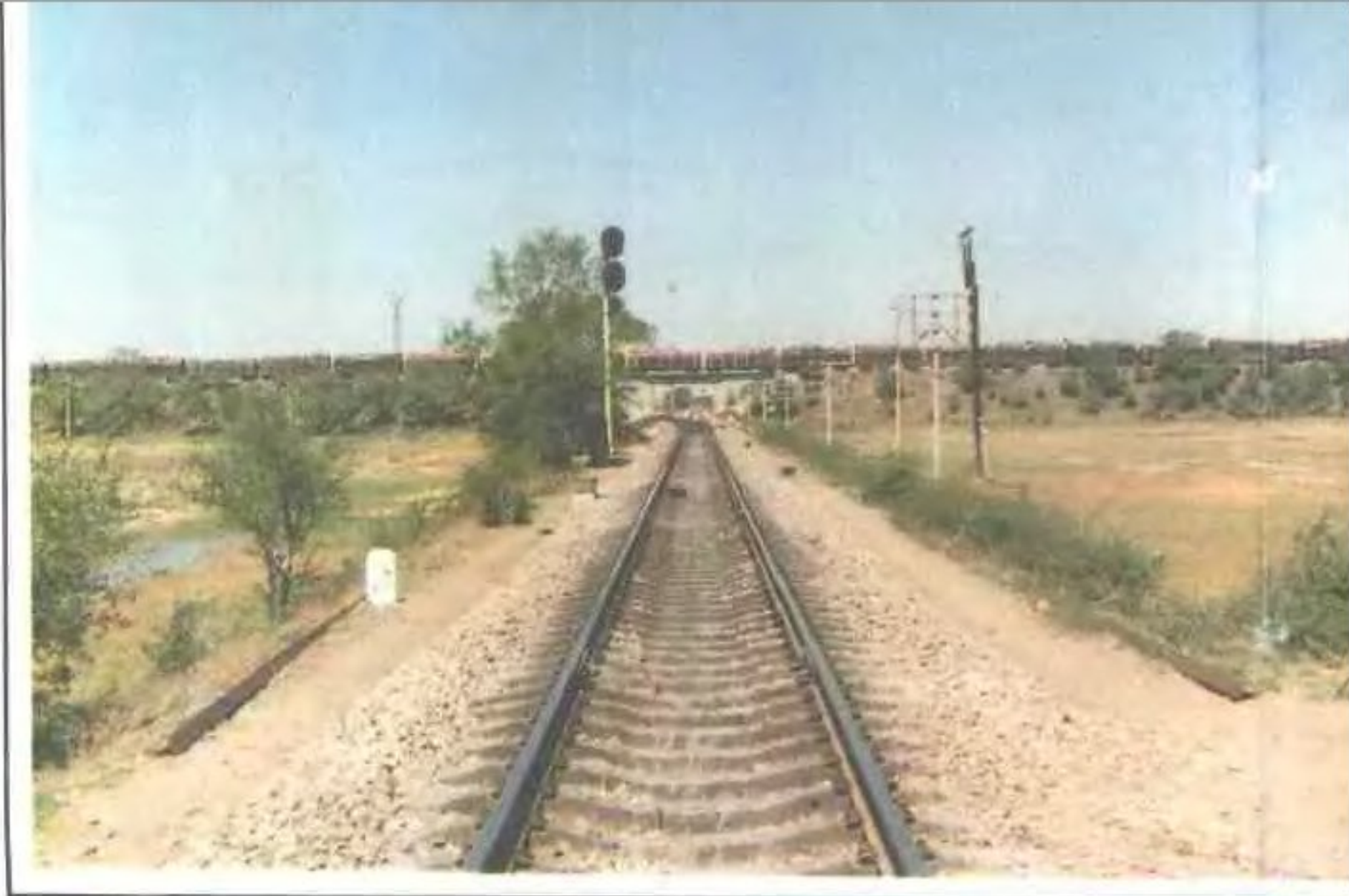
平齐线跨越滨洲线立交桥
