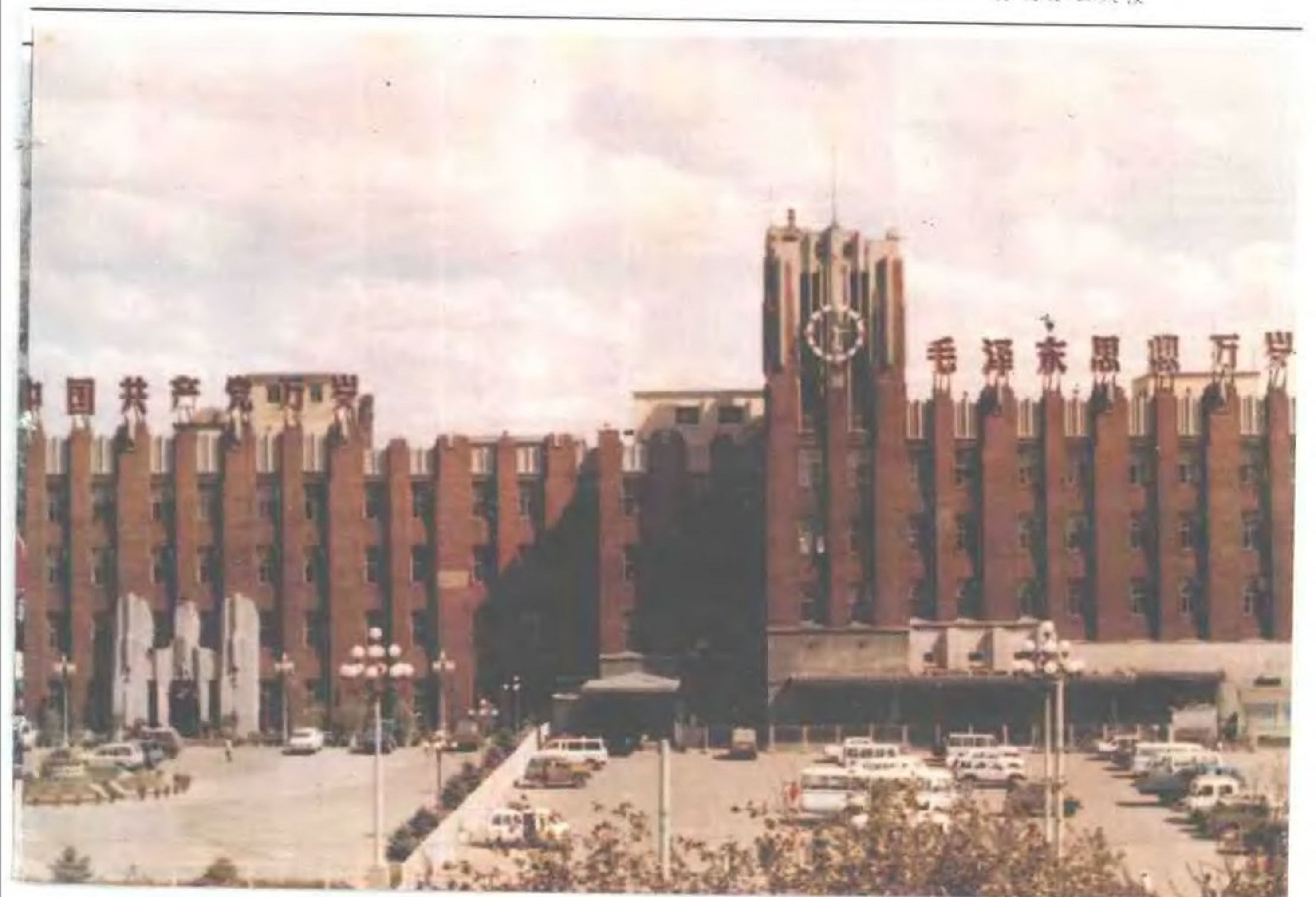
分局办公大楼
