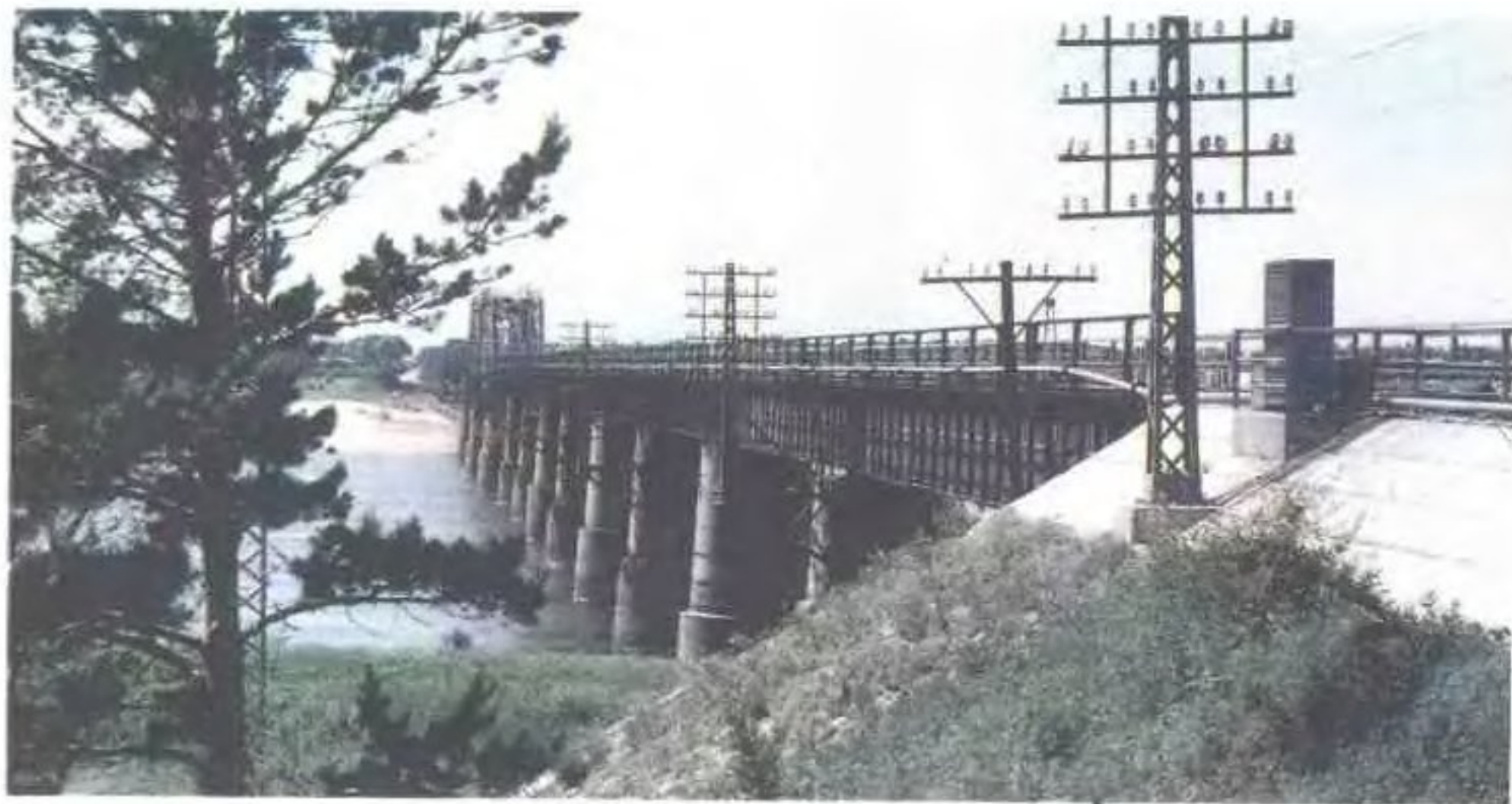
平齐线 504 公里特大桥
