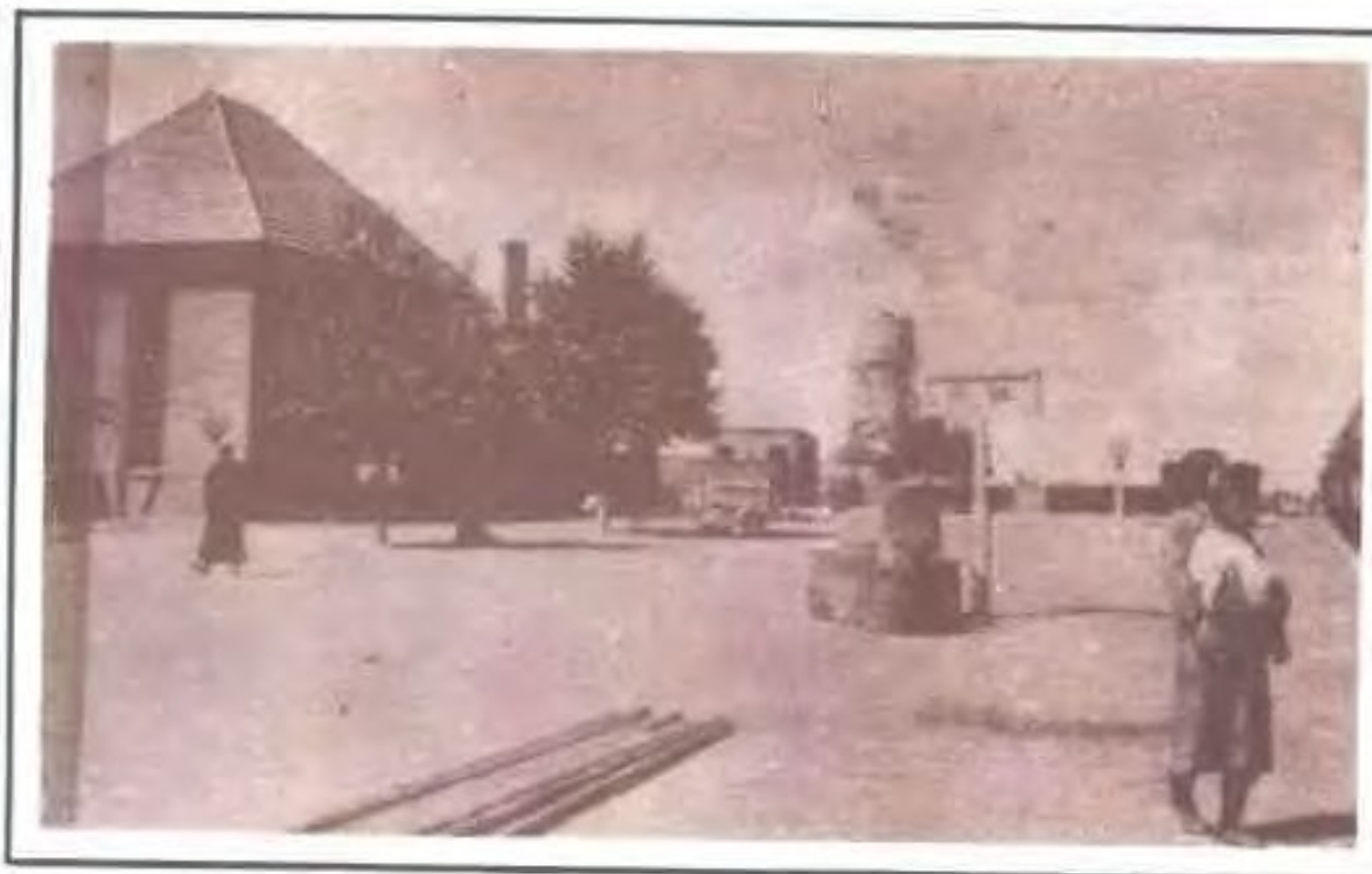
洮昂路江桥站
