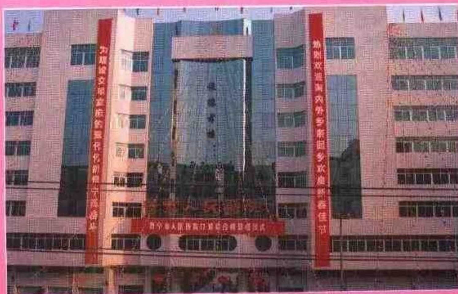
▲ 医院门诊综合楼外貌
